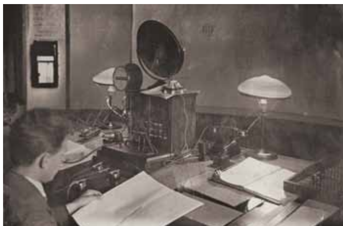
Диспетчерский пункт объединения Уралэнерго (фото 1935 г.)
