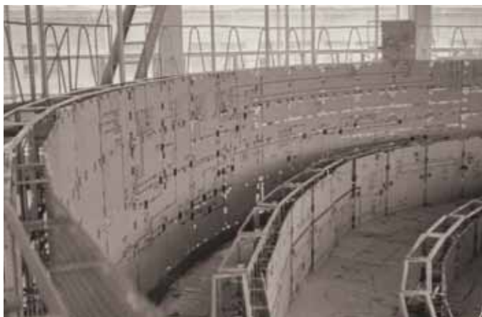
Монтаж щита в ЦДУ ЭЭС СССР (фото 1974 г.)
