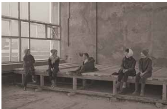
Сотрудники ЦДУ ЭЭС СССР на субботнике по строительству зала техникумы, в настоящее время в нем находится Центр тренажерной подготовки персонала ОАО «СО ЭЭС» (фото 1972 г.)
