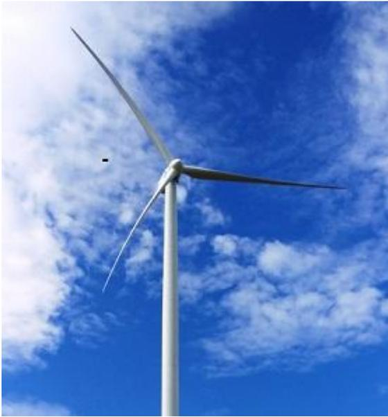
Заклученный контракт является крупнейшим для Siemens Gamesa в Таиланде. Установленные на площадке ВЭС Хануман ветровые турбины будут самыми высокими в Азиатском регионе. Так, высота оси ветроустановки составит 153 м, и с учетом длины лопасти, равной 62 м, высота турбины в верхней точке составит 215 м.
