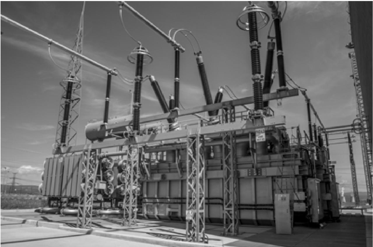
Необходимость установки ФПТ обусловлена значительными неплановыми перетоками электроэнергии между странами. За счет использования регулировочных возможностей ФПТ системные операторы Чехии и Германии рассчитывают обеспечить возможность гибкого регулирования мощности трансграничных перетоков (до 900 МВ), что повысит устойчивость работы и эффективность управления пропускной способностью трансграничных связей.
