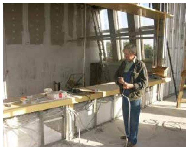
Реконструкция центра тренажерной подготовки персонала, 2004 год
