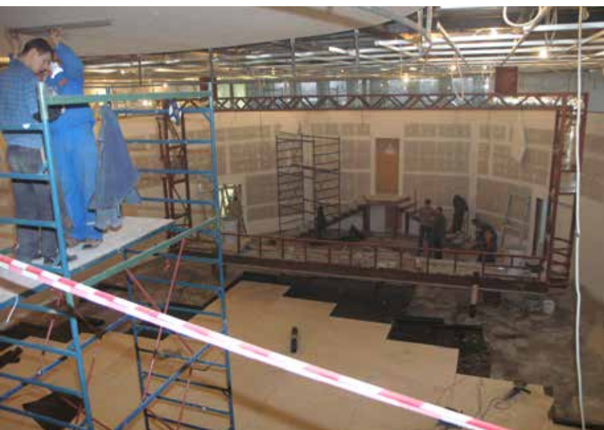
Установка диспетчерского щита в ОДУ Северо-Запада, 2005 год
