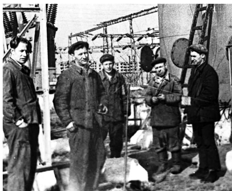
Подстанция Южная – первый уральский энергообъект напряжением 220 кВ
