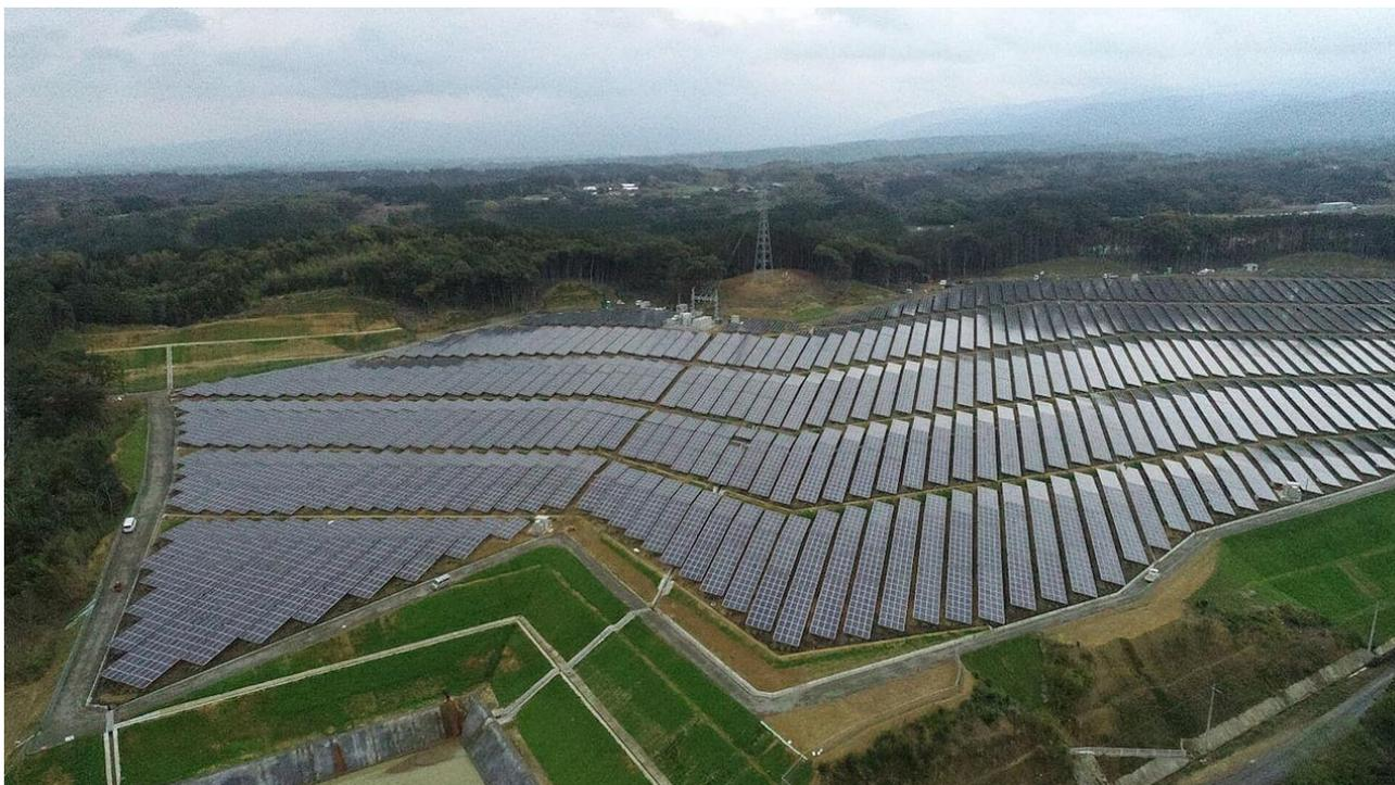
СЭС расположена в холмистой местности на площади 24 га в провинции Идзуми (префектура Кюсю Кагосима). СЭС состоит из 31 248 солнечных фотоэлектрических панелей, а ее выработки, по мнению собственников, должно хватить для обеспечения электроэнергией порядка 5 тыс. местных домохозяйств.
