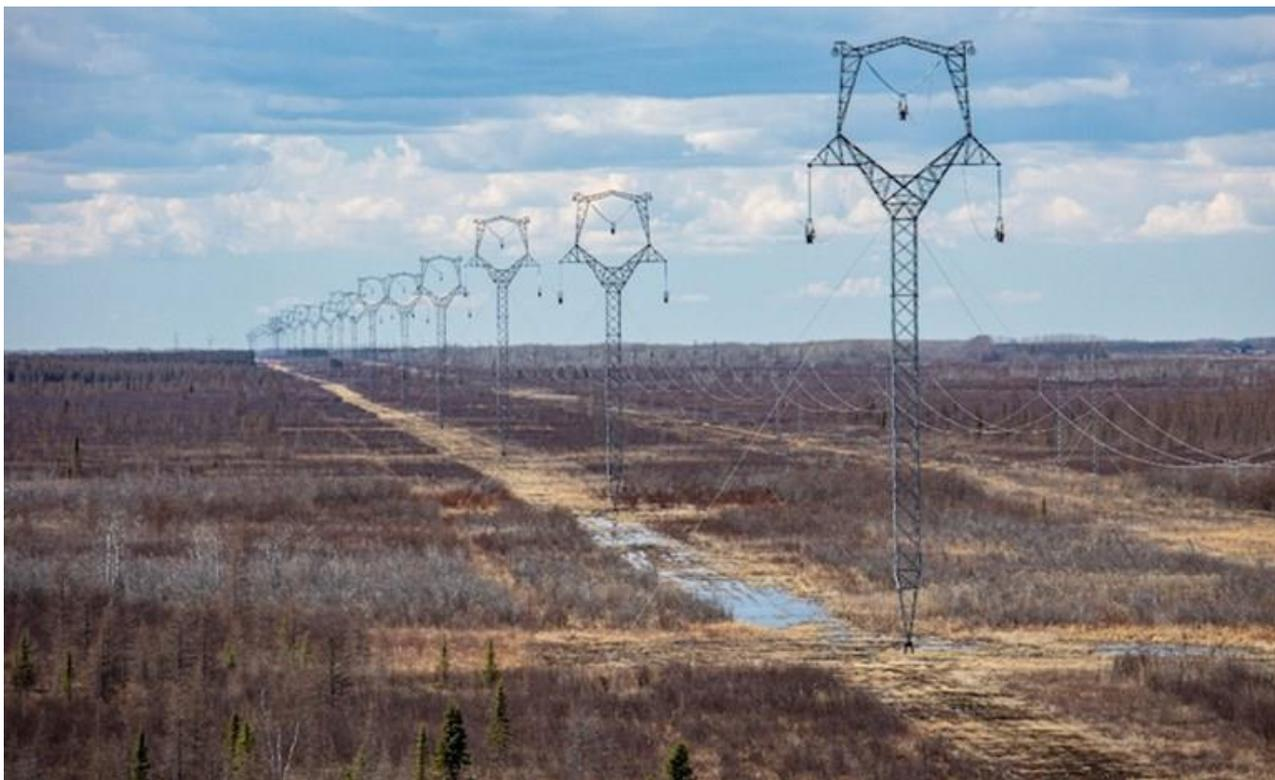
Новое трансграничное соединение протяженностью  $\approx 360$  км и пропускной способностью 250 МВт проходит на канадской территории от ПС Dorsey до ПС Riel и далее до границы с США, затем уже по территории Миннесоты, где ЛЭП подключена к ПС Iron Range.
