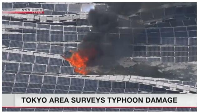
По мнению пожарных, возгорание было вызвано тем, что из-за сильного ветра сложились солнечные панели, что вызвало интенсивный рост температуры на их поверхности и в дальнейшем переросло в пожар. Загорелось около 50 панелей.
