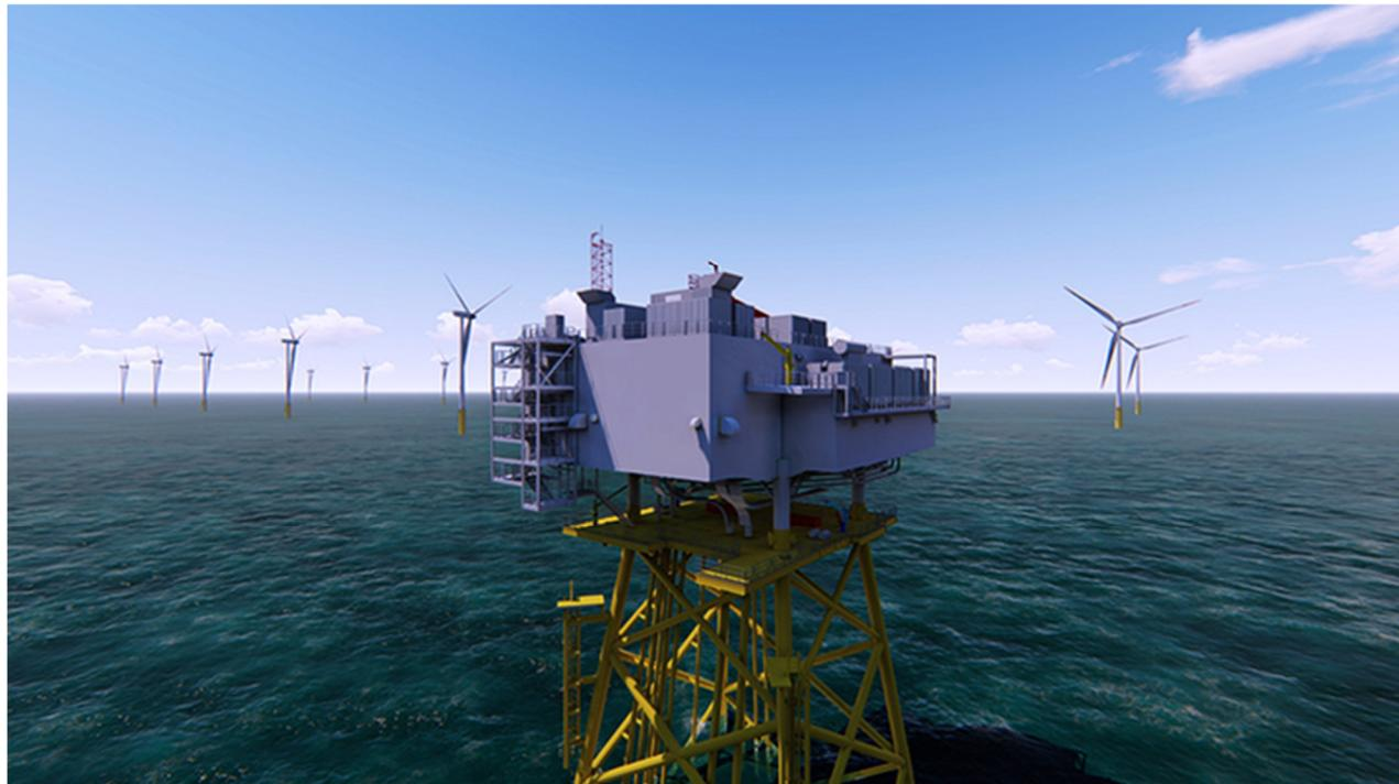
На ВЭС Fécamp общей мощностью 500 МВт будет установлена 71 ветровая турбина производства компании Siemens Gamesa Renewable Energy (SGRE) SWT-7.0-154 мощностью 7 МВт каждая. Строительство станции будет осуществляться в проливе Ла-Манш на расстоянии от 13 до 22 км от побережья г. Fécamp, расположенного на северо-западе Франции в регионе Нормандия. Гравитационные фундаменты будут установлены на глубине 25 - 30 м.
