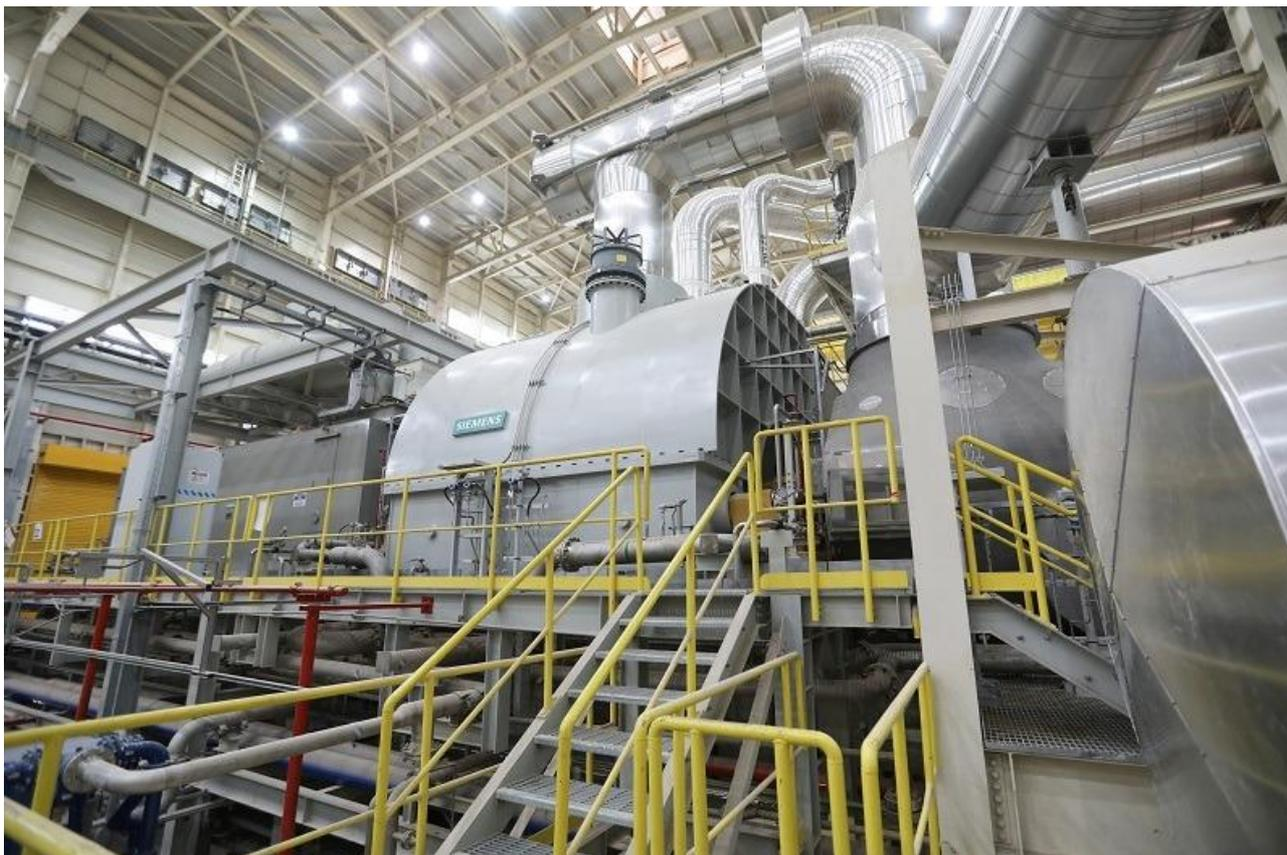
немецким концерном Siemens в апреле 2018 г., последний поставил для ПГЭС Al Houl Power 6 газовых турбин SGT5-4000F, четыре паровые турбины SST5-4000 и десять генераторов SGen5-1200A со вспомогательным оборудованием для управления и контроля. Кроме того, с Siemens подписано сервисное соглашение на обслуживание станции сроком на 25 лет.
