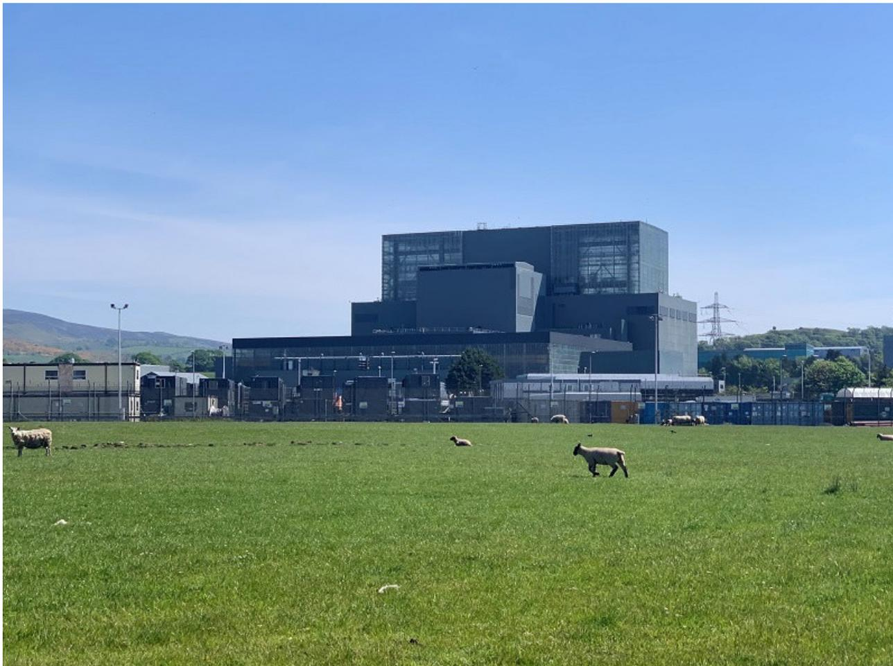
АЭС Hunterston B является второй очередью АЭС Hunterston A<sup>2</sup>. На АЭС Hunterston B электрической мощностью 1 220 МВт установлено 2 усовершенствованных ядерных реактора с газовым охлаждением (Advanced Gas-cooled Reactor, AGR). Станция была введена в эксплуатацию в 1976 г. В 2012 г. срок эксплуатации АЭС был продлен до марта 2023 г. с возможностью его изменения на два года в любую сторону.
