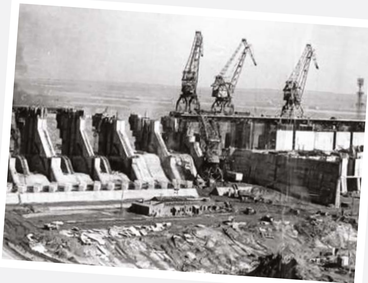
Строительство Воткинской ГЭС
