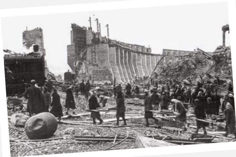
Восстановление Днепрогэс. 1944 год
