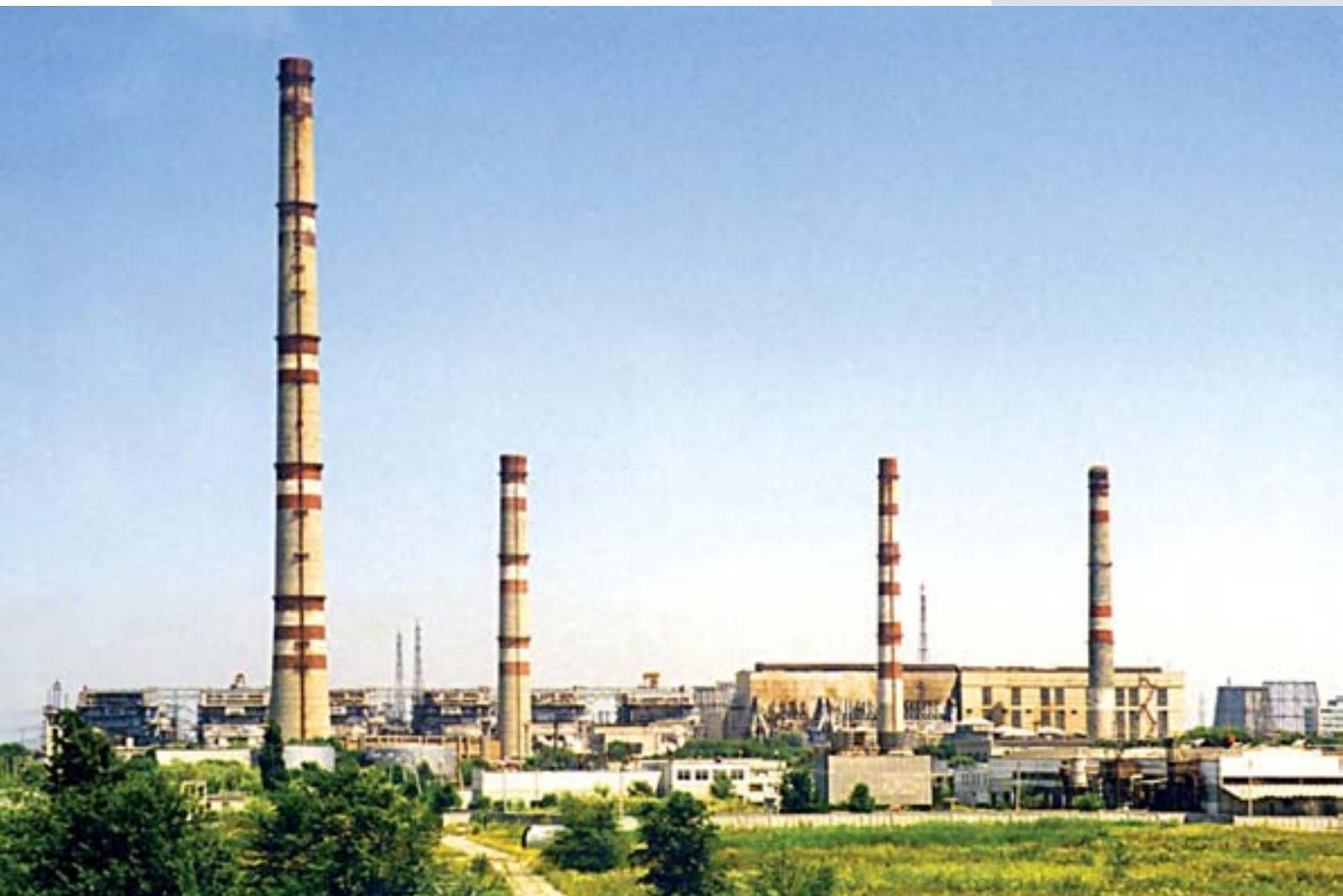
*Новочеркасская ГРЭС. Проектная мощность — 2400 МВт (2 моноблока и 6 дубль-блоков по 300 МВт). Начало строительства — 1961 год. Первый блок введен в эксплуатацию в 1965 году, последний — в 1972 году*
