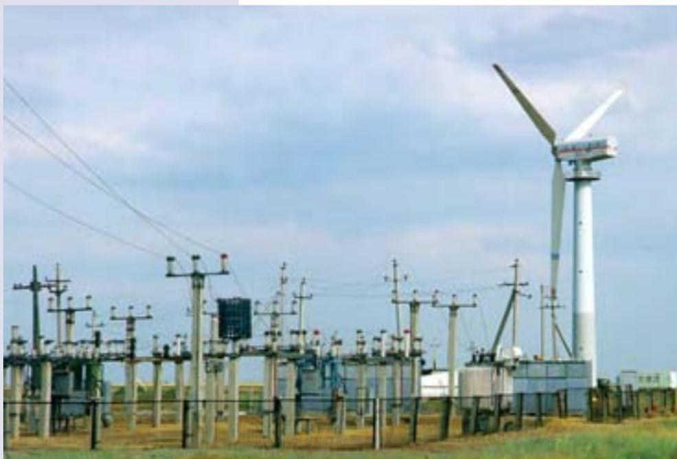
*Калмыцкая ВЭС. Проектная мощность — 22 МВт (1х22). В 1995 году введена в эксплуатацию единственная из 22 ветроэлектрическая установка*
