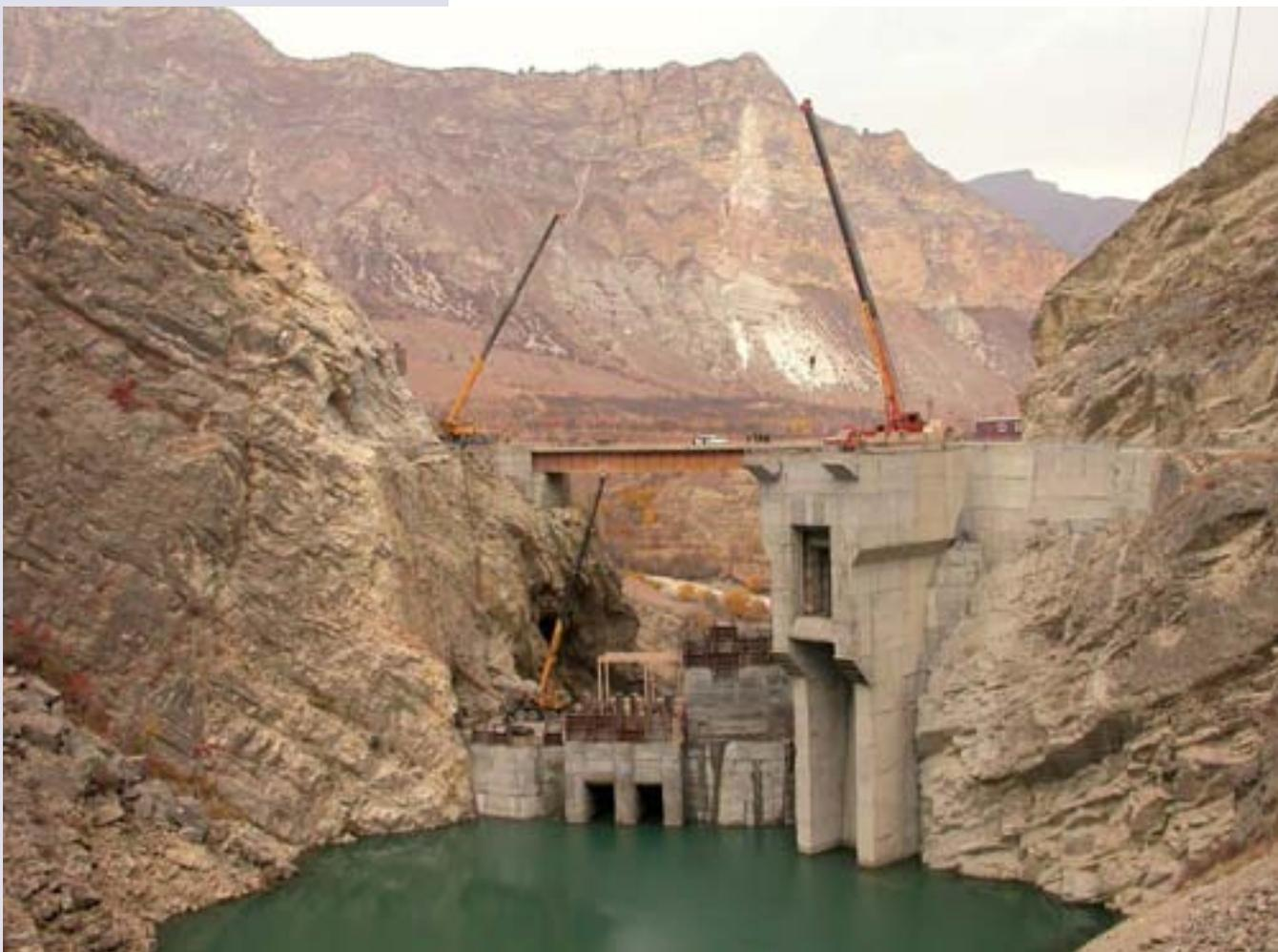
Гунибская ГЭС. Панорама строительства. Установленная мощность — 15 МВт (5 x 3). Первая из электростанций, построенная по разработанной «Дагэнерго» технологии типового строительства малых ГЭС «Прометей». Начало строительных работ — 1997 год, ввод в эксплуатацию — 2005 год
