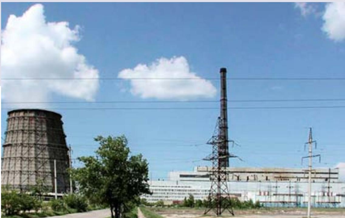
*Астраханская ТЭЦ-2. Установленная мощность — 380 МВт. Начало строительства — 1981 год. В 1985 году были включены в работу два турбоагрегата по 80 МВт, в 1987 и 1990 гг. — соответственно третий и четвертый по 110 МВт*
