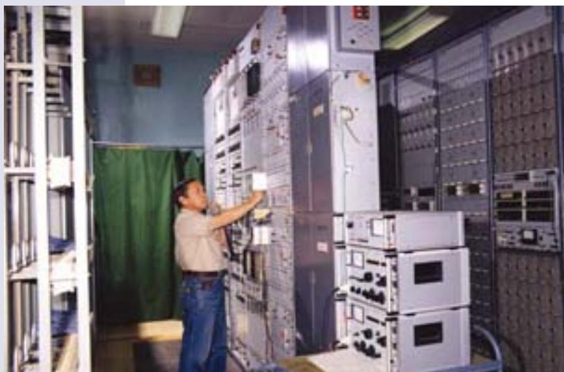
*Аппаратура уплотнения кабельных каналов связи ТН-12, 1998 год*
