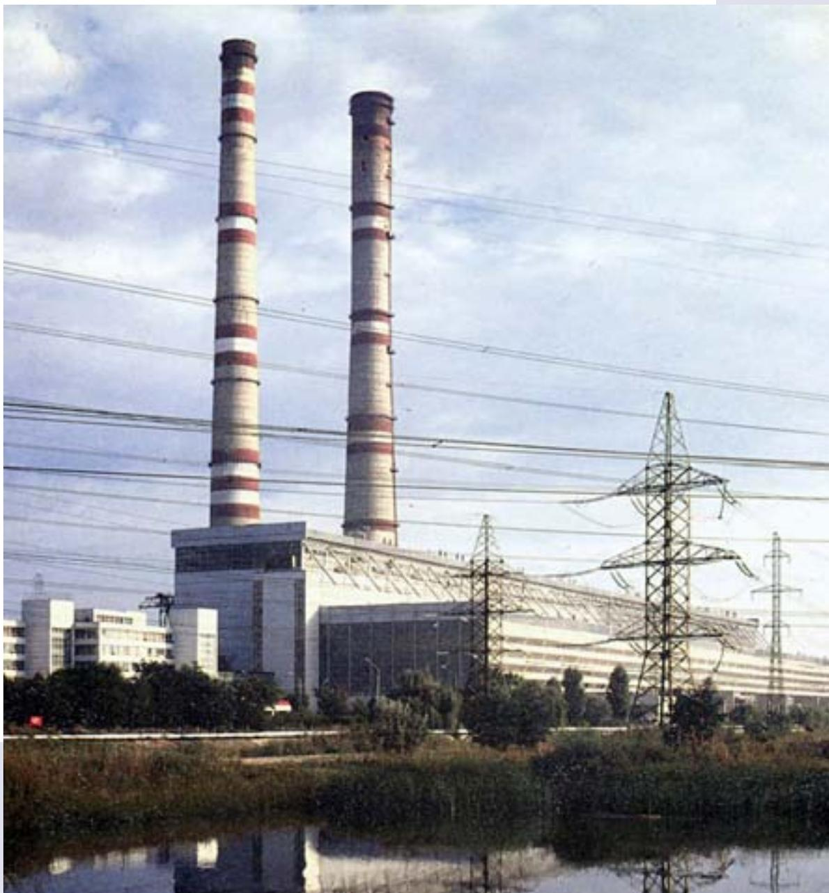
*Ставропольская ГРЭС, 1985 год. Первый блок второй очереди (№ 5) синхронизирован и включен в сеть в 1978 году. С включением в работу последнего энергоблока (№ 8) станция выведена на проектную мощность 2400 МВт*
