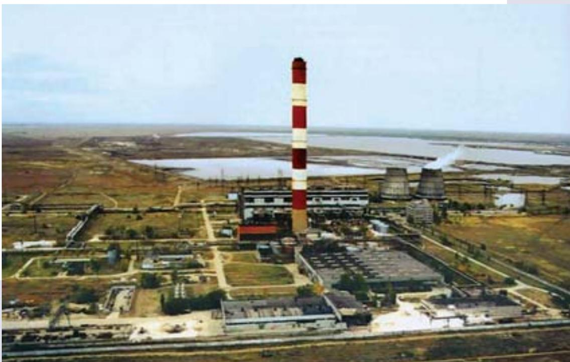
*Волгоградская ТЭЦ-3. Установленная мощность — 296 МВт. Начало строительства — 1973 год, пуск первого турбоагрегата — 1977 год, последнего — 1981 год. На станции впервые в СССР установлены малабаритные газоплотные котлы ТГМЭ-428 производительностью 500 т пара в час*
