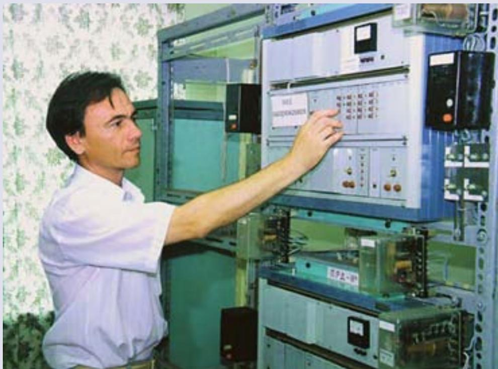
*Лаборатория РЗА и противоаварийной автоматики ОДУ Северного Кавказа. Контроль аппаратуры АКПА-В, предназначенной для передачи сигналов противоаварийной автоматики из ОДУ на энергообъекты*
