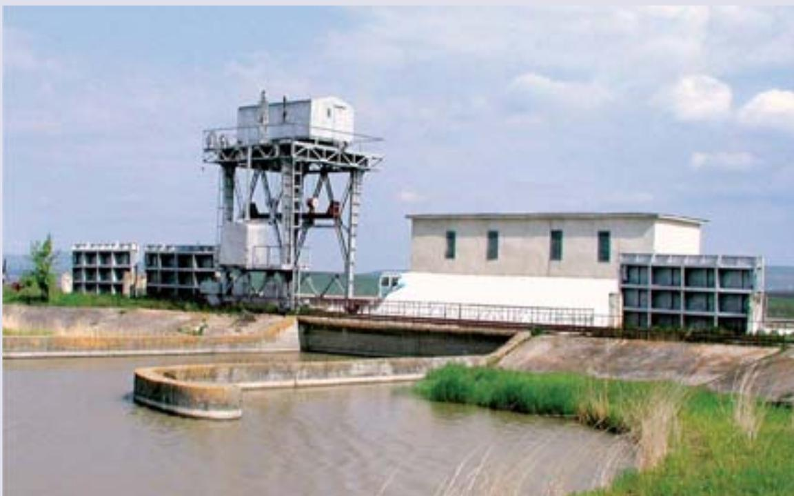
*ГАЭС (гидроаккумулирующая электрическая станция). Мощность в турбинном режиме — 15,9 МВт (6х2,65), в насосном режиме — 14,4 МВт (6х2,4). Первый агрегат введен в 1968 году, последний — в 1969-м. ГАЭС Кубанского каскада — первая в СССР гидроаккумулирующая электрическая станция, работающая в сезонном цикле*
