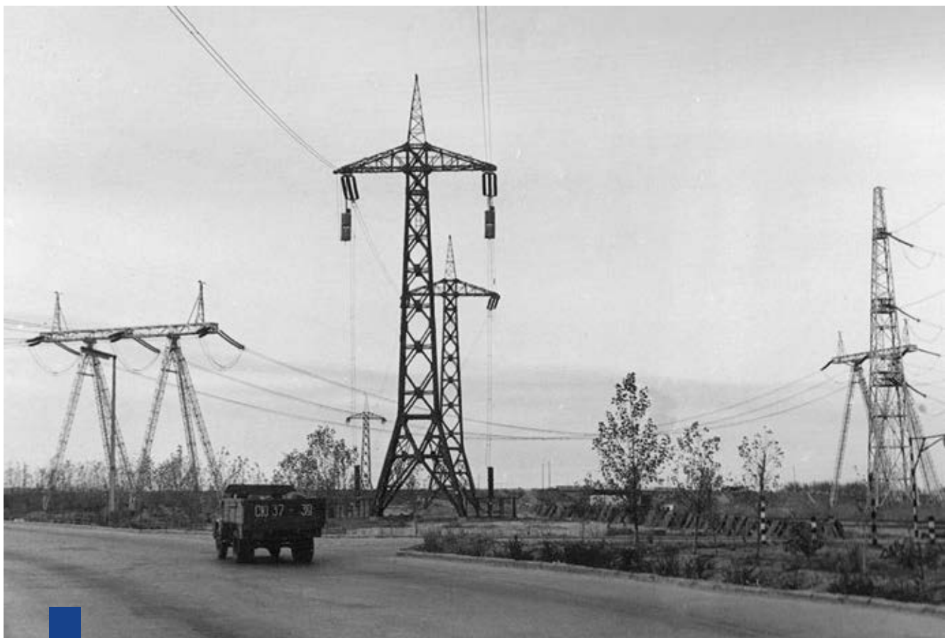
Линия электропередачи 800 кВ постоянного тока Волгоград – Донбасс, 1962 год
