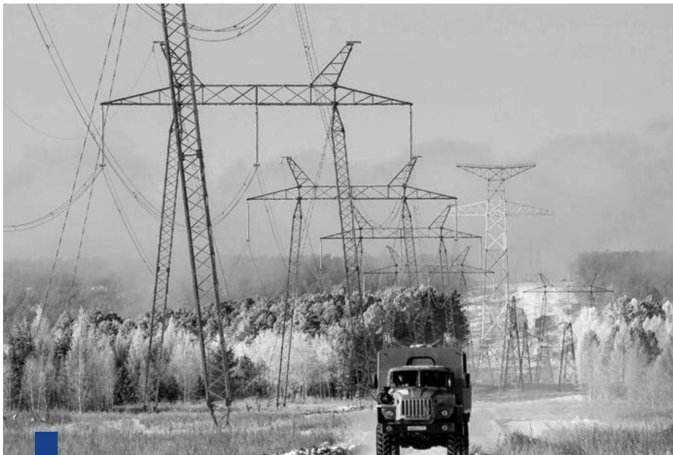
ВЛ 500 кВ Зейская ГРЭС – Амурская, 2000-е годы
