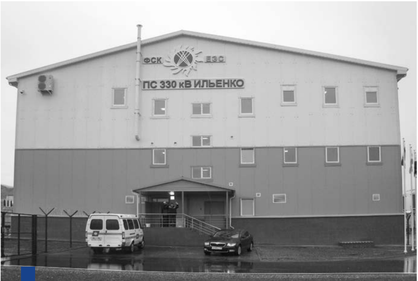
Подстанция 330 кВ Ильенко, 2015 год
