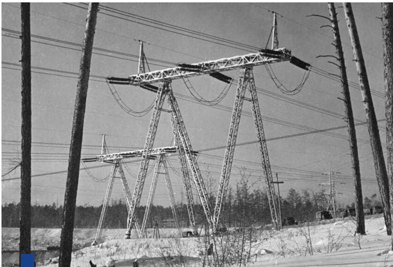
ЛЭП 500 кВ Братская ГЭС – Красноярск, 1965 год
