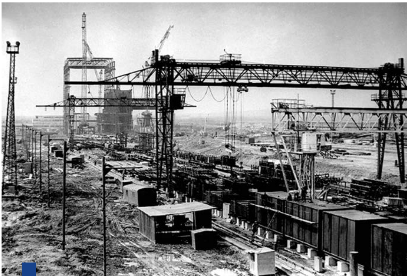
Строительство Хабаровской ТЭЦ-3, 1975 год
