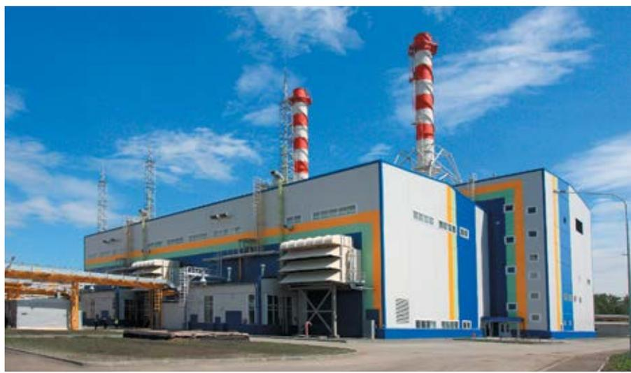
*Челябинская ГРЭС: по программе ДПМ в 2014 году введены два энергоблока установленной мощностью 225 МВт каждый*
