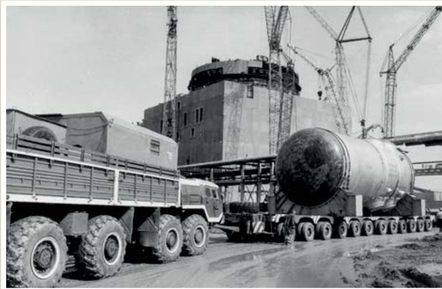
*Транспортировка реактора ВВЭР-1000 на строящийся энергоблок № 1 Ростовской АЭС, 1988 год*
