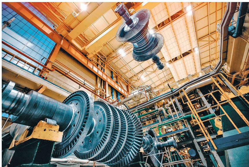
Рис. 2. Ротор паровой турбины на Кольской АЭС
