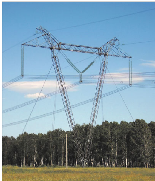
Опоры ЛЭП 1150 кВ
