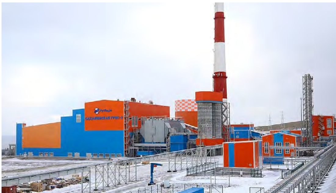
Введенная в эксплуатацию в ноябре 2019 года Сахалинская ГРЭС-2 спроектирована с учетом высокой сейсмостойкости и и тайфуноустойчивости
