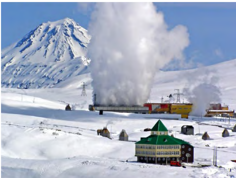
Расположенная в долине вулкана Мутновская ГеоЭС на Камчатке – крупнейшая геотермальная электростанция в России
