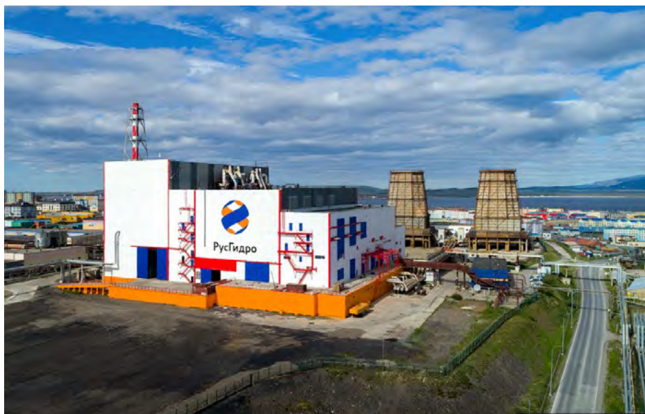
Анадырская ТЭС – самая крупная теплоэлектростанция на Чукотке, введена в эксплуатацию в 1986 году
