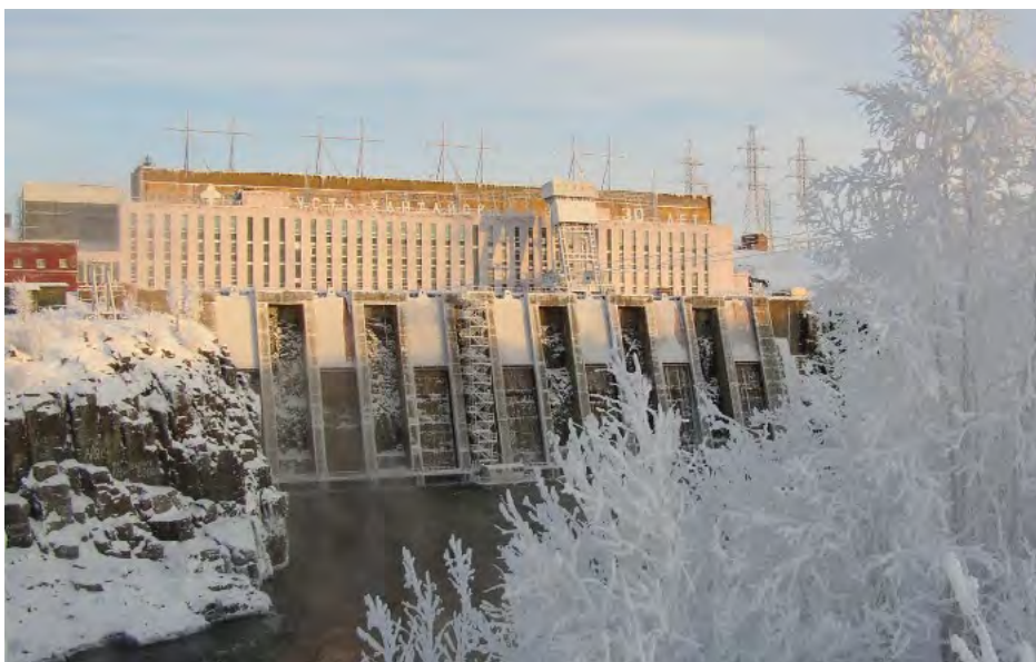
Расположенная в 160 км от Норильска в поселке Снежногорск Усть-Хантайская ГЭС – одна из самых северных гидроэлектростанций в мире
