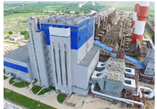
Энергоблок № 9 Новочеркасской ГРЭС, Ростовская область
