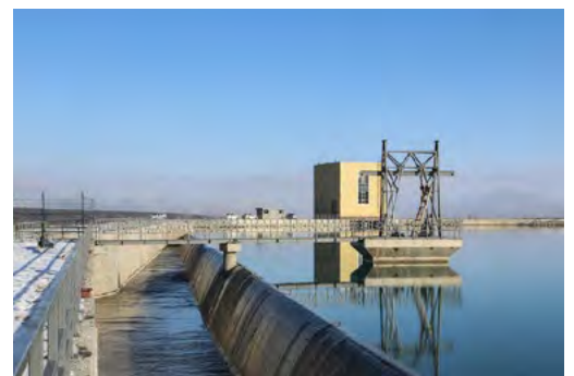
Водоброс Зарагжской ГЭС
