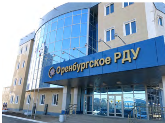
Здание Оренбургского РДУ
