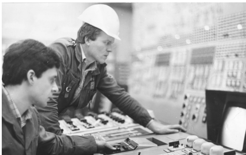
Сергей Сюткин на щите управления ТЭЦ-26 Мосэнерго, 1988 год
