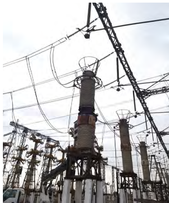
Подвесной линейный разъединитель ВЛ 500 кВ
