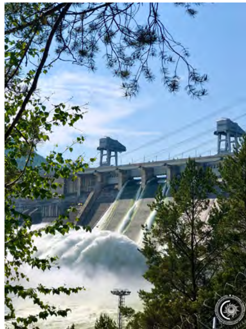
«Красноярская ГЭС. Водосброс»
