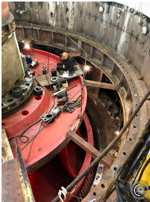
«Красноярская ГЭС. Ремонт»
