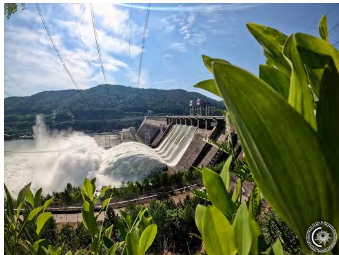
«Красноярская ГЭС. Зеленая энергетика»
