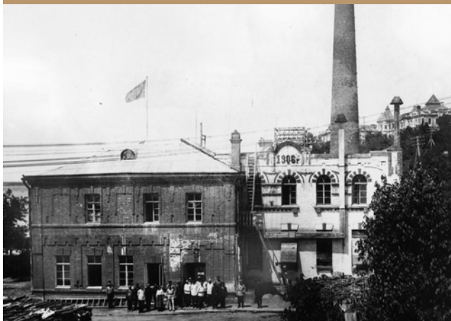
Первая на Дальнем Востоке городская электростанция на снимке 1923 года – за 12 лет до закрытия. Впоследствии именно тут находился первый диспетчерский пункт, откуда в годы Великой Отечественной войны осуществлялось управление новой ХЭС, электростанциями заводов им. Молотова, Кагановича и нефтеперерабатывающего и рядом других источников генерации.
