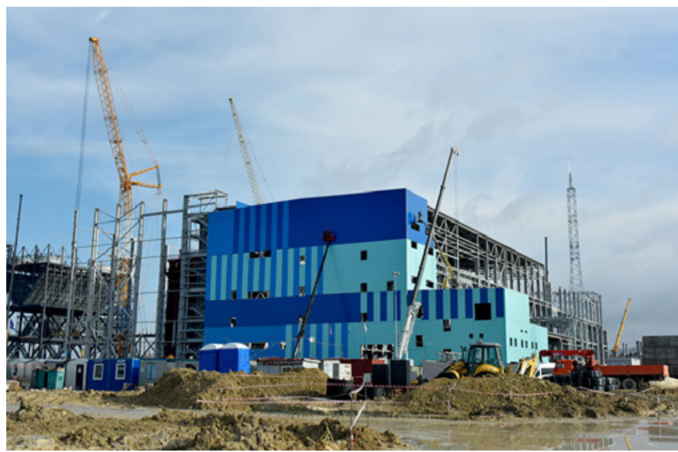
Строительство Симферопольской ПГУ-ТЭС
