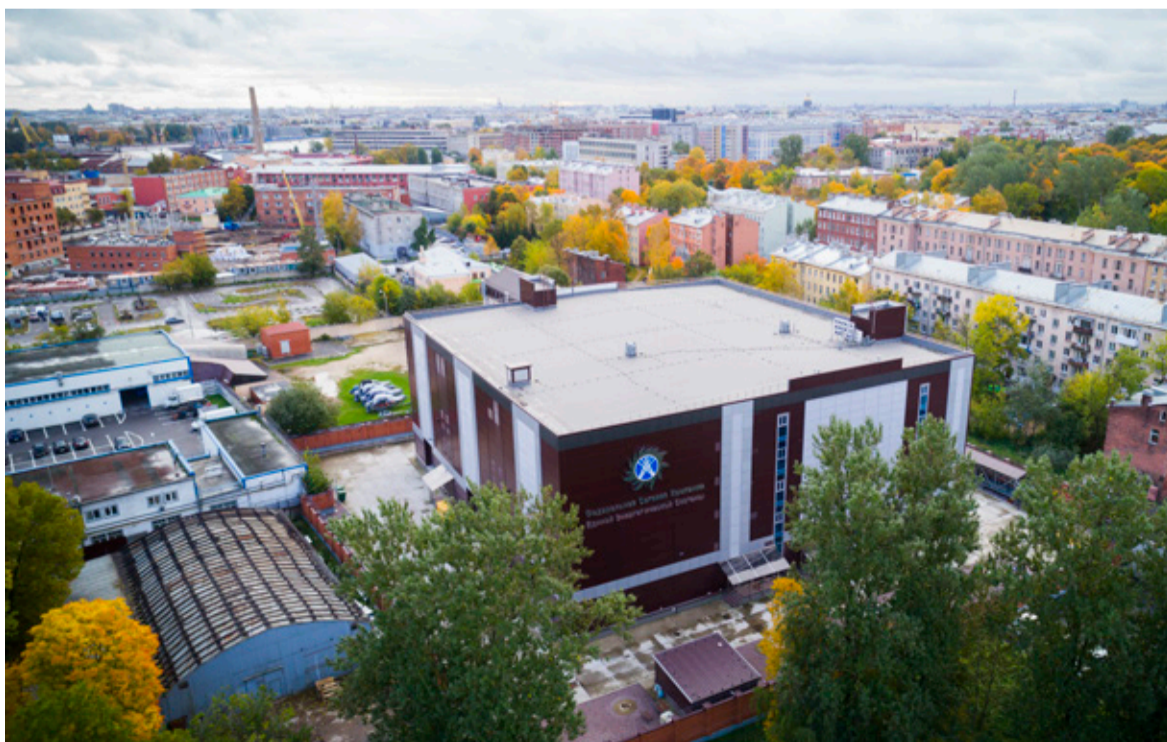
ПС 330 кВ Василеостровская
