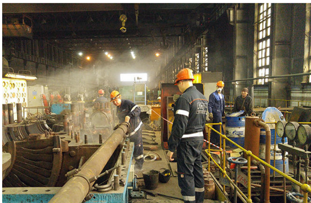
Капитальный ремонт на Воркутинской ТЭЦ-2
