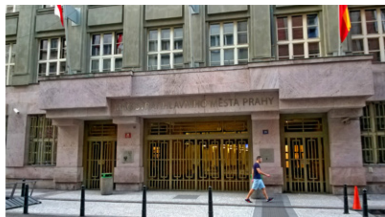
Бывшее здание концерна «Шкода» на улице Юнгманова в самом центре Праги, два этажа которого занимало ЦДУ энергосистемы «Мир». Сейчас здесь находится муниципалитет чешской столицы, 2017 год.
