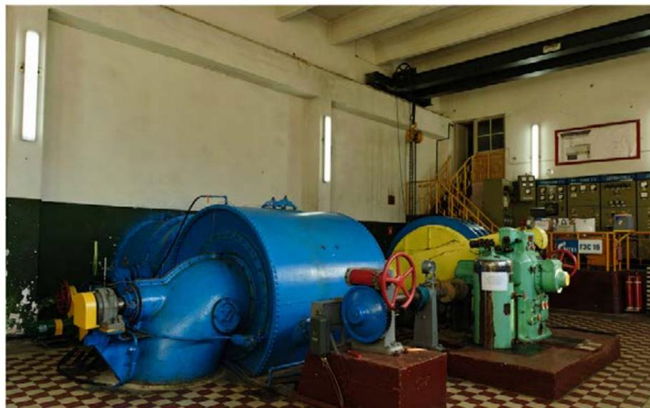
Станция Питкякоски оборудована всего одним гидроагрегатом мощностью 1,26 МВт
