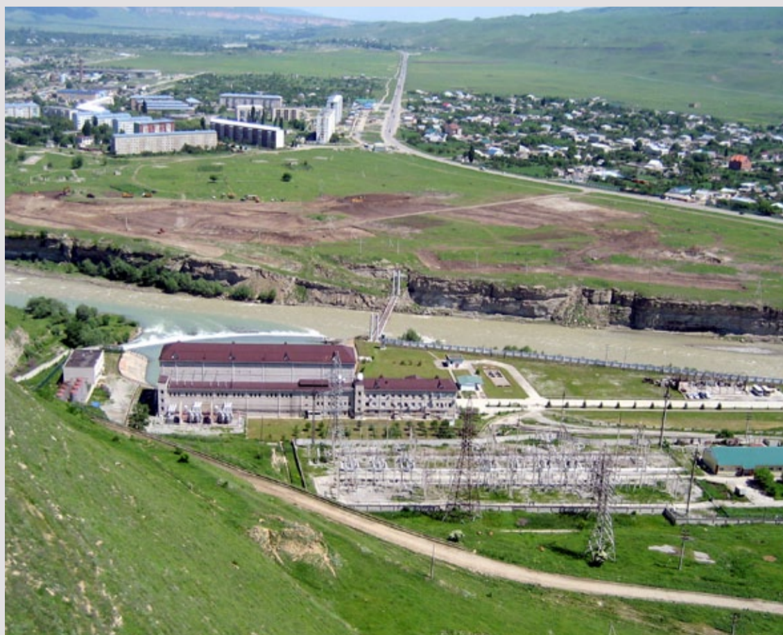
Зеленчукская ГЭС – ГАЭС
