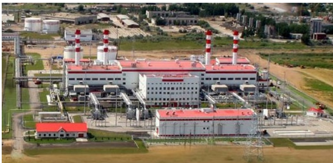
Новая ПГУ-235 Центральной котельной
