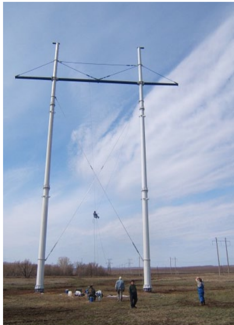
Строительство ВЛ 500 кВ Красноармейская – Газовая
