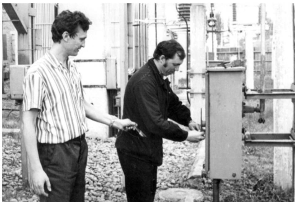
Краснодарское предприятие электрических сетей. Оперативные переключения на ПС-220 кВ производят Г. Федарков и электромонтер В. Якунин. 1975 год
