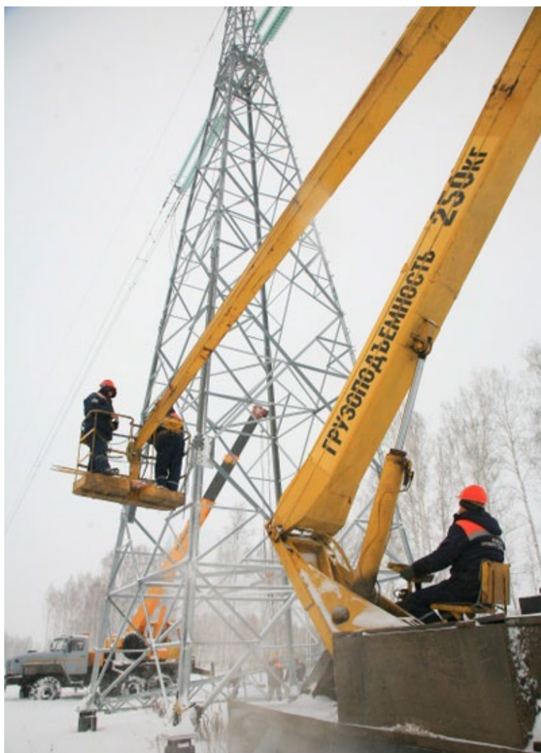
Строительство ВЛ 500 кВ Курган – Ишим (Витязь) – Восход
