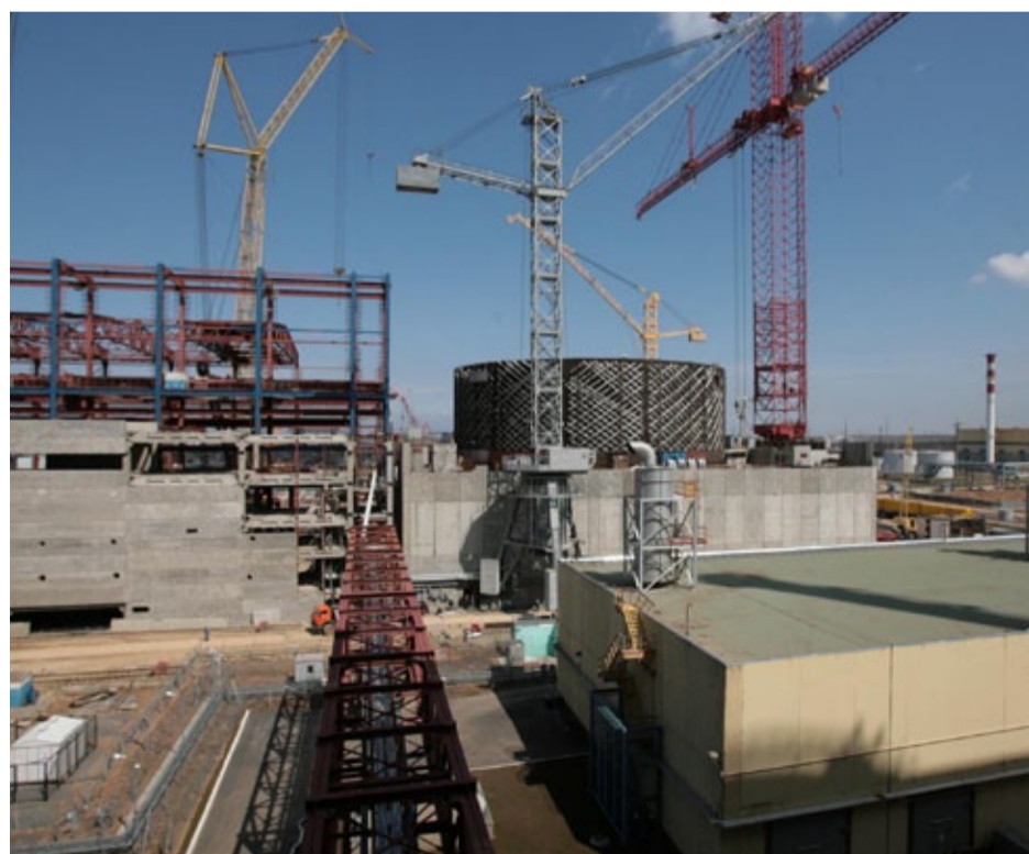
Строительство 3-го энергоблока Ростовской АЭС
