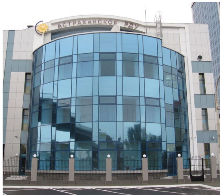
Новое здание Астраханского РДУ
