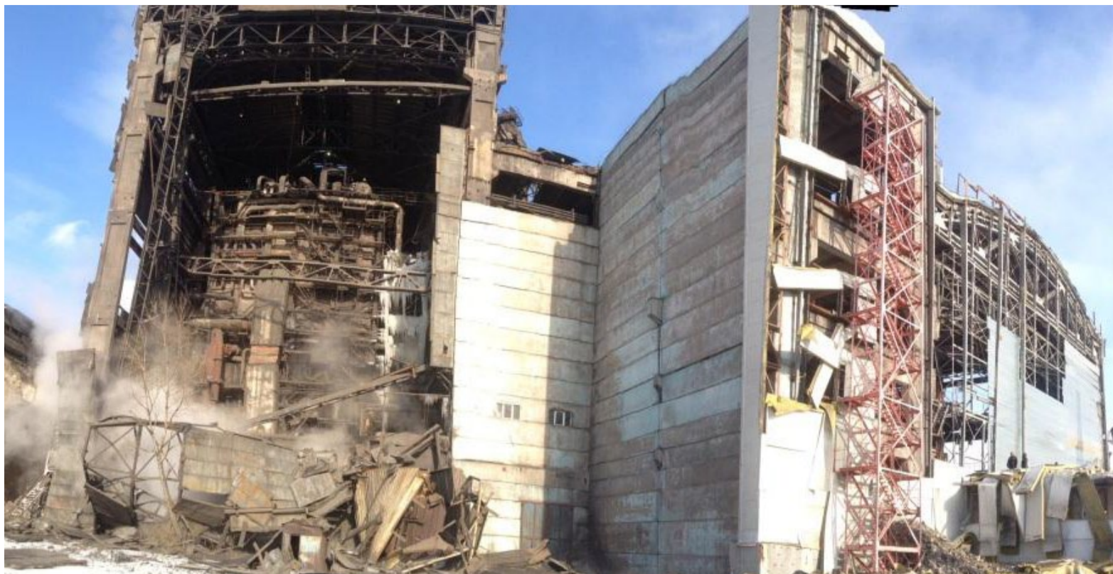
Авария на Западно-Сибирской ТЭЦ. Март 2014 г.
