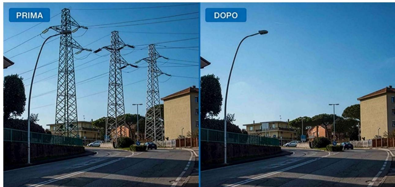
Проект, в который Terna инвестирует € 60 млн, предусматривает прокладку около 17 км новых подземных КЛ и демонтаж в общей сложности 171 опоры на протяжении более 40 км действующих ВЛ, построенных в 1970-х годах и проходящих через густонаселенные районы. В результате станет возможным использовать для иных целей более 130 га, входивших в охранную зону ВЛ.
