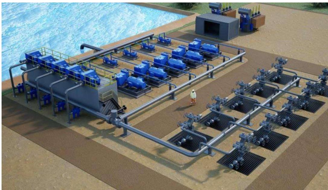
Для ГеоНЭ EarthStore использовалась выведенная из эксплуатации в 2008 г. геологоразведочная скважина, пробуренная компанией Shell в штате Техас, в которую в течение пяти недель закачивалась вода с одновременным измерением давления и объема. Для выработки электроэнергии использовались гидротурбины Пелтона.
