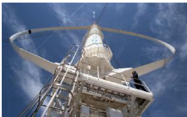
Экспериментальная ветротурбина Sandia National Laboratories с вертикальной осью (проект 1980-х годов)
