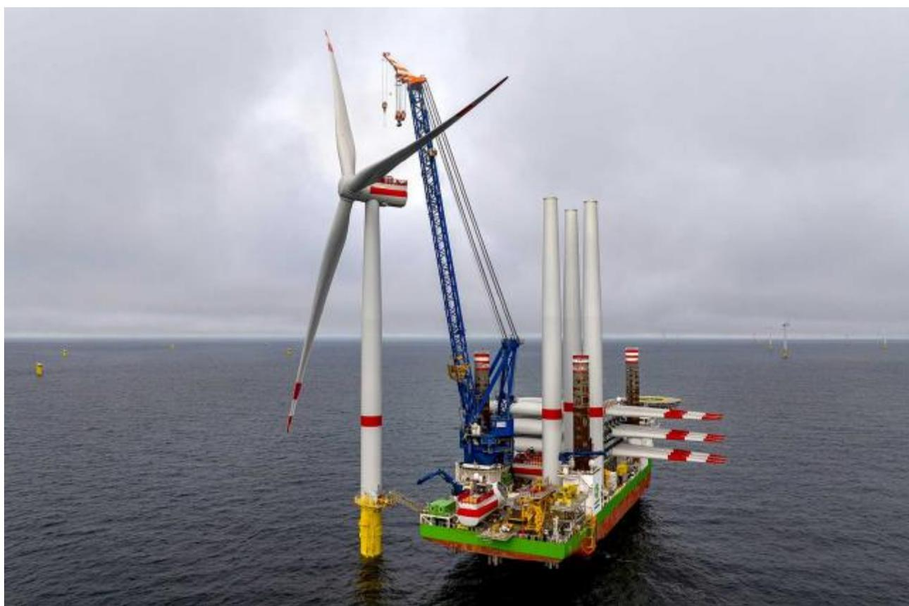
Диаметр ротора каждой турбины составляет 167 м, высота ступицы – 107,5 м. Впервые для турбин были использованы лопасти RecyclableBlades длиной 81 м с возможностью последующей переработки по окончании их эксплуатационного срока.
