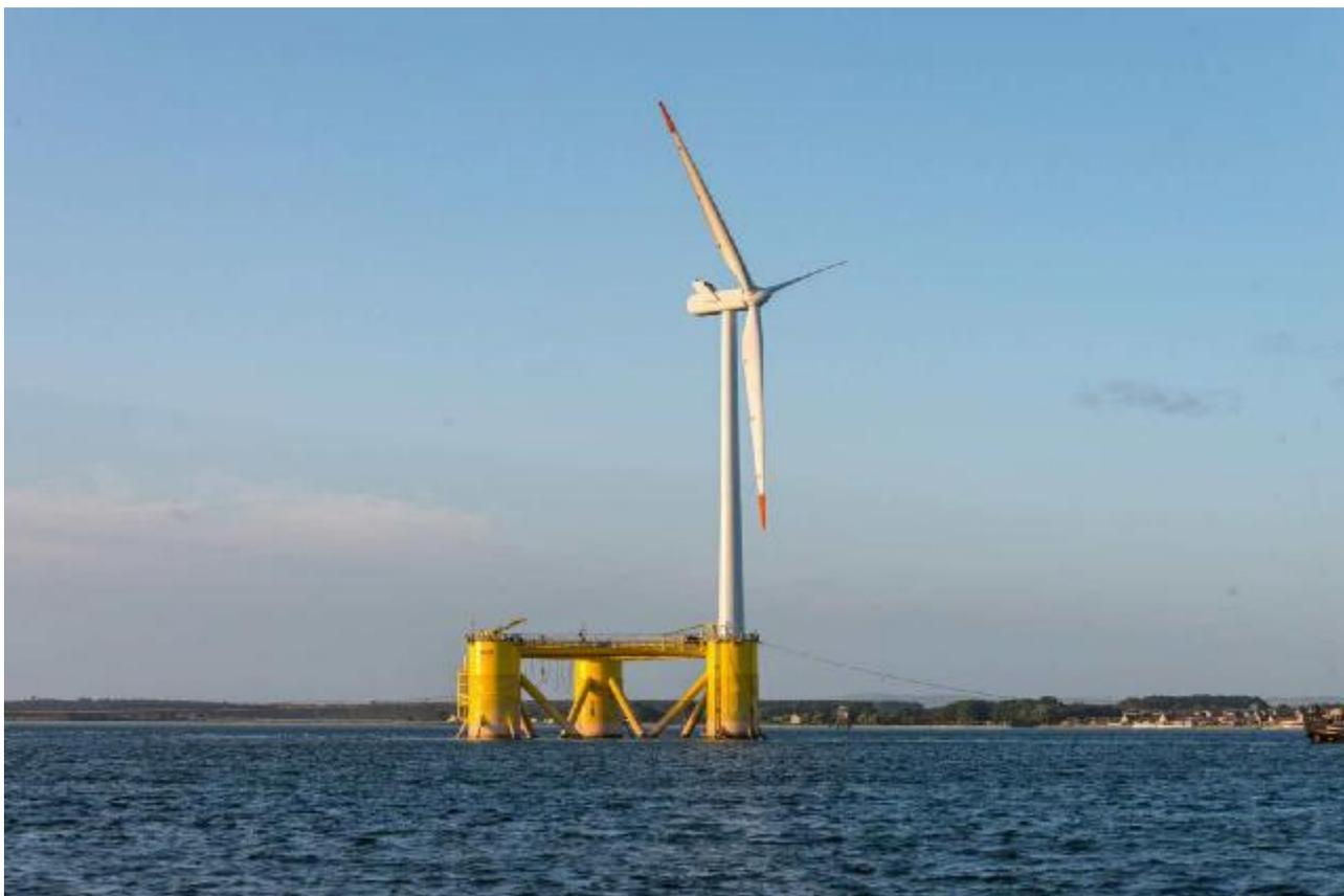
На ВЭС Кинкардайн установлено пять ветровых турбин мощностью по 9,5 МВт и ветровая турбина мощностью 2 МВт. Турбины установлены на треугольных полупогружных основаниях (triangular semi-submersible foundations),
