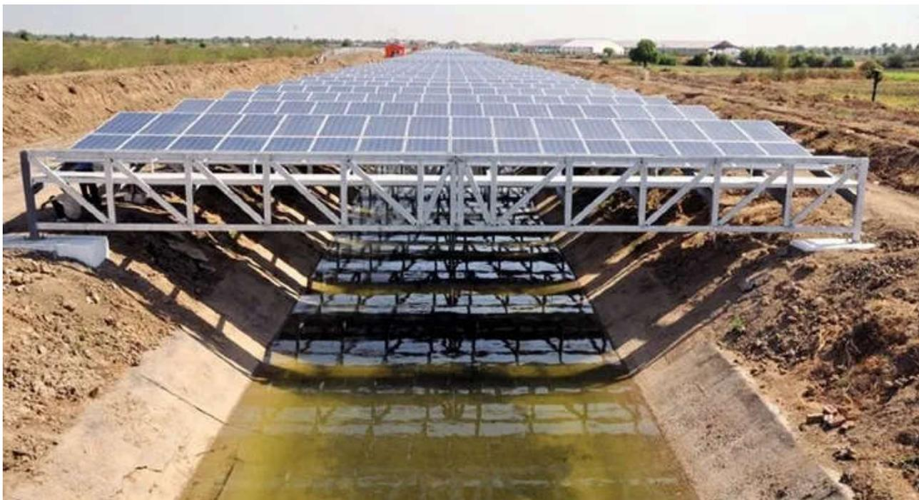
В соответствии с проектом оросительный канал длиной 177 км, доставляющий воду в центральные и южные области Наварры, будет оборудован фотоэлектрическими панелями суммарной пиковой мощностью 160 МВт.
