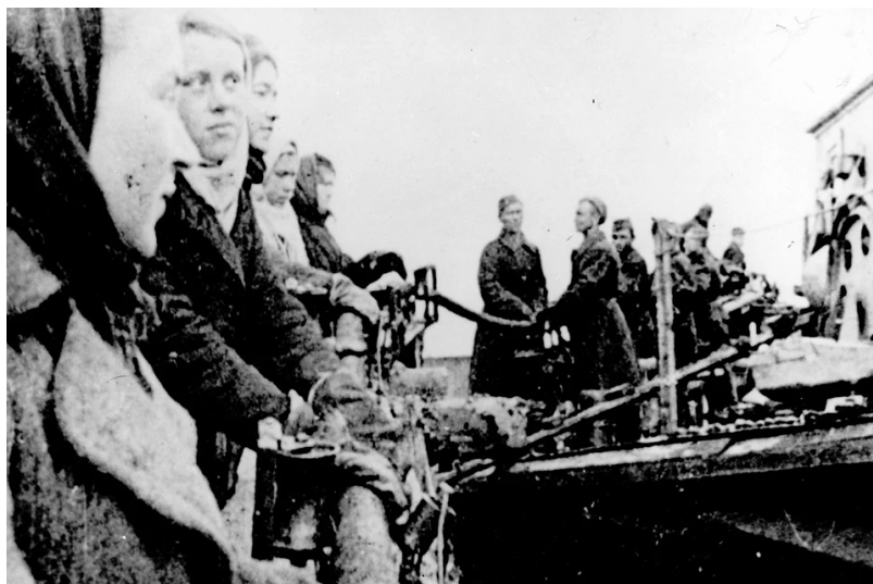
Укладка кабеля жизни на дно Ладожского озера. Фрагмент кабеля жизни хранится сегодня в музее ОДУ Северо-Запада
