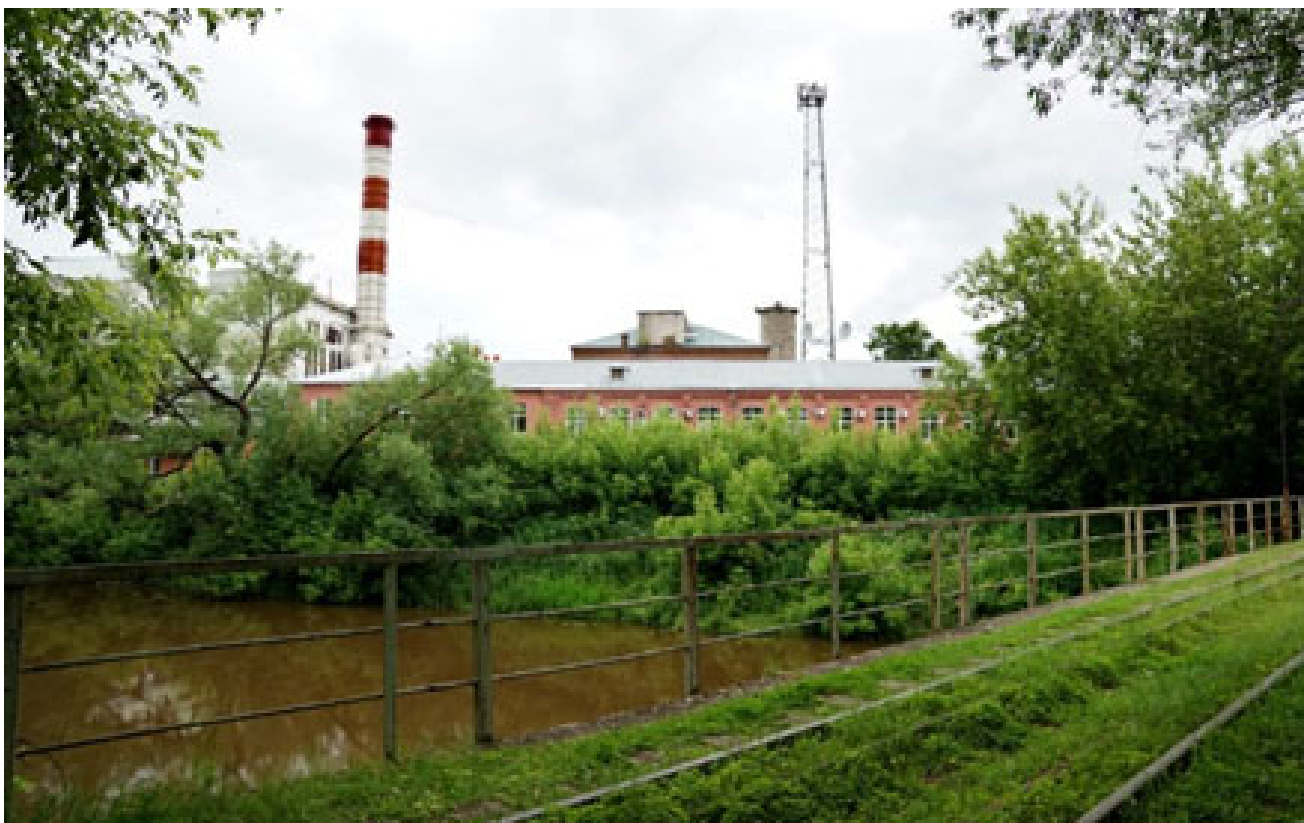
Старейший областной энергообъект Тверская ТЭЦ-1 и сегодня обеспечивает теплоснабжение Пролетарского района города
