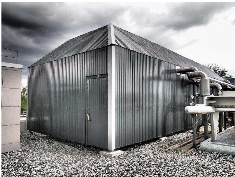
Рисунок 1. Пермское РДУ. Шумозащитная конструкция (вид 1)
