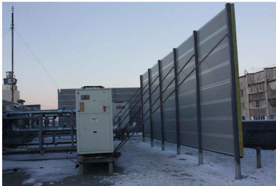
Рисунок 6. Челябинское РДУ. Шумозащитный экран
