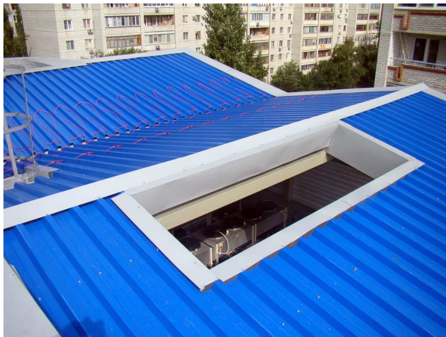
Рисунок 2. Волгоградское РДУ. Шумозащитная конструкция (вид 2)
