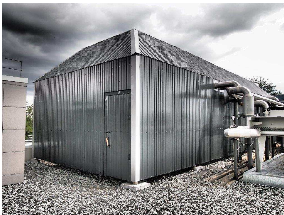
Рисунок 3. Пермское РДУ. Шумозащитная конструкция (вид 1)
