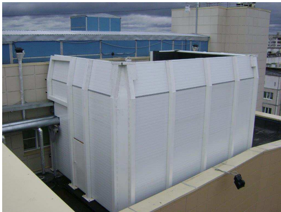
Рисунок 5. Тюменское РДУ. Шумозащитная конструкция
