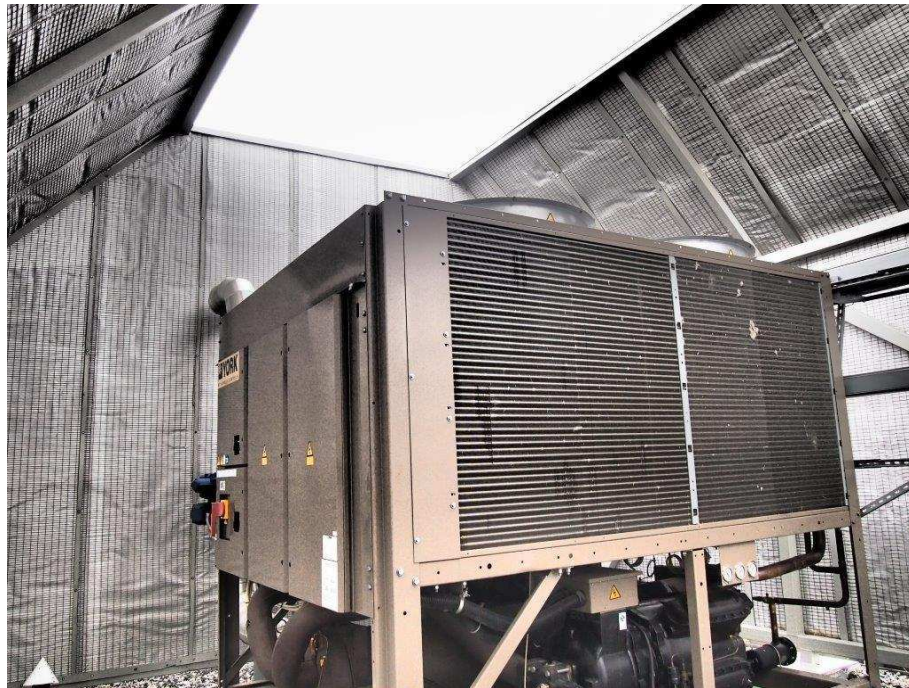
Рисунок 4. Пермское РДУ. Шумозащитная конструкция (вид 2)
