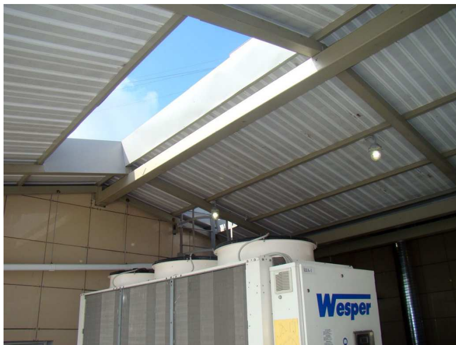
Рисунок 1. Волгоградское РДУ. Шумозащитная конструкция (вид 1)
