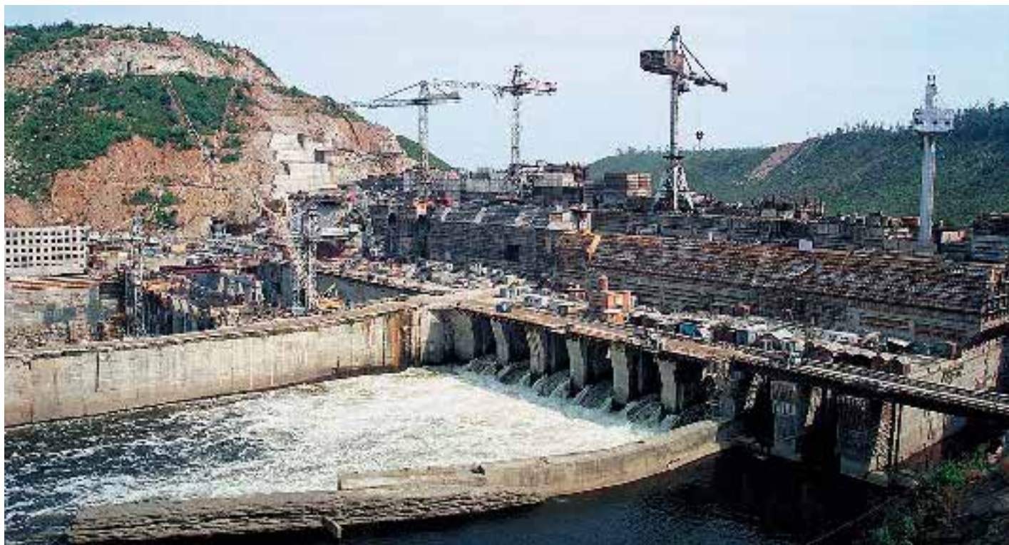
Строительство Бурейской ГЭС
