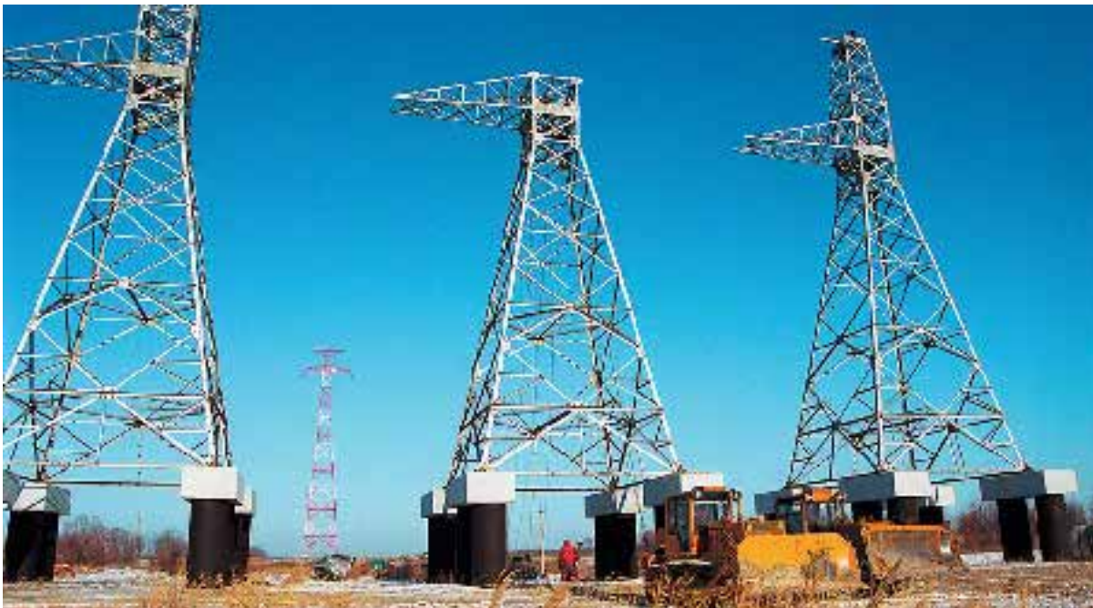
Строительство энергоперехода через Амур. 2002 год
