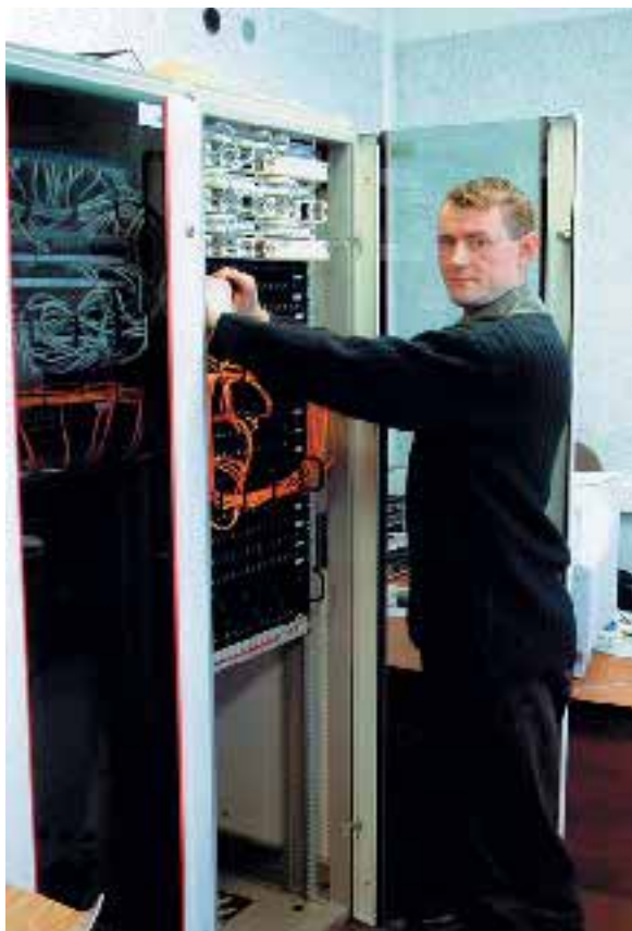
А.С. Масленко. Монтаж ЛВС
