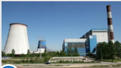
4 Южная ТЭЦ-22 энергоблок 450 МВт
