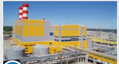
6 Уренгойская ГРЭС энергоблок 450 МВт
