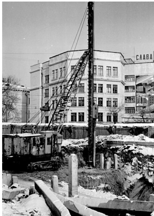
Строительство здания ОДУ Востока, 1983–1993 годы
