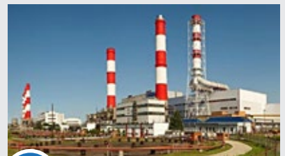
9 ТЭЦ-21 Мосэнерго энергоблок 425 МВт
