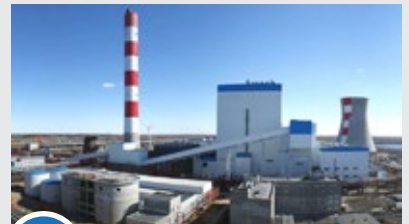
3 Троицкая ГРЭС энергоблок 660 МВт
