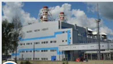
8 Ярославская ТЭС энергоблок 450 МВт
