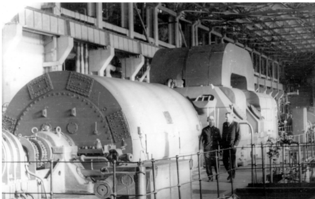
В машинном зале Райчихинской ГРЭС (Валентин Смирнов справа), 1969 год
