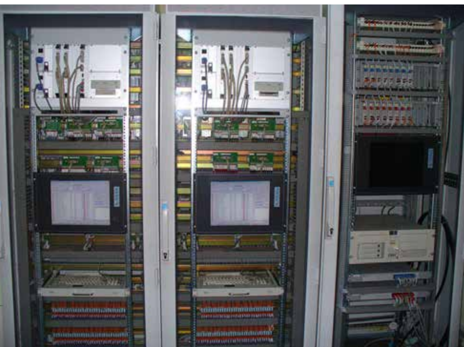
Комплекс противоаварийной автоматики АПНУ
