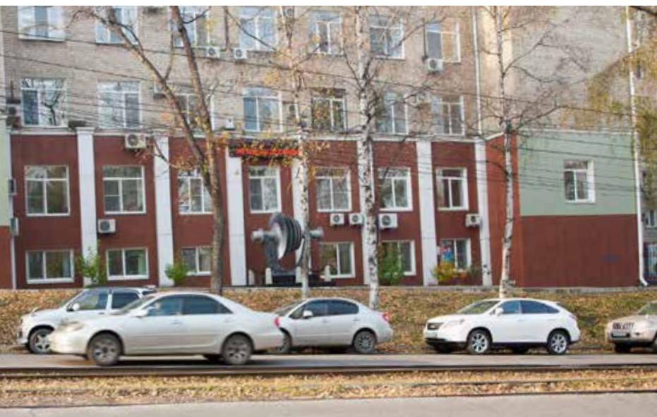
В этом здании на улице Шеронова размещалась ЦДС «Хабаровскэнерго»
