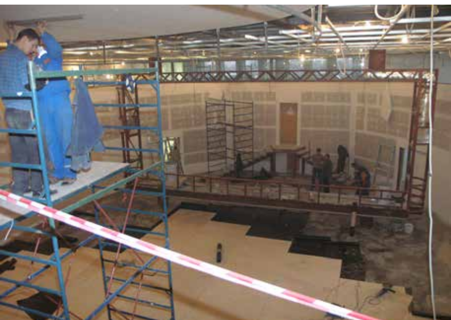
Установка диспетчерского щита в ОДУ Северо-Запада, 2005 год
