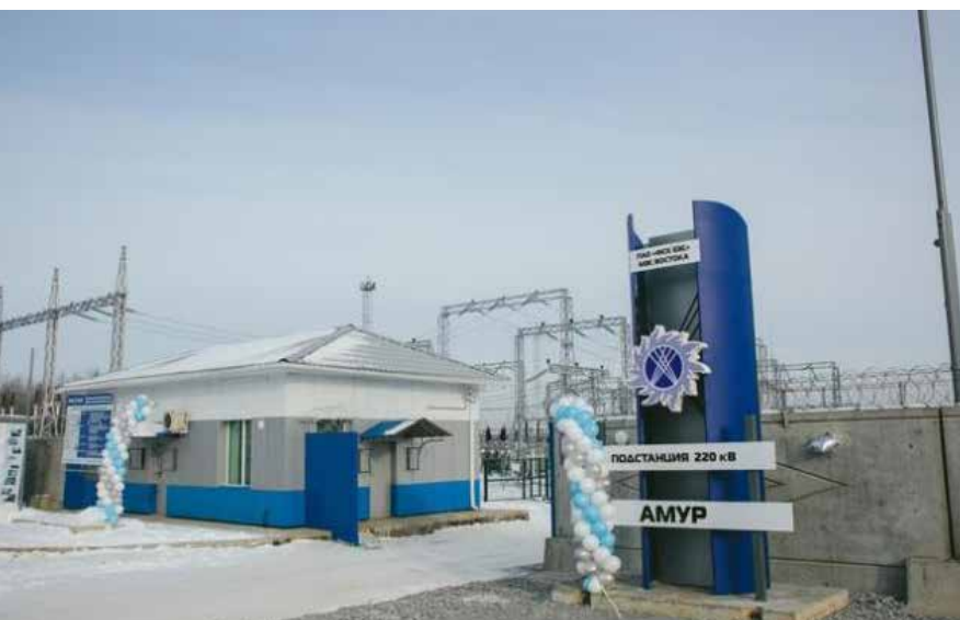
На подстанции Амур, включенной в работу в 2016 году, впервые в регионе применены компактные распределительные устройства с элегазовой изоляцией
