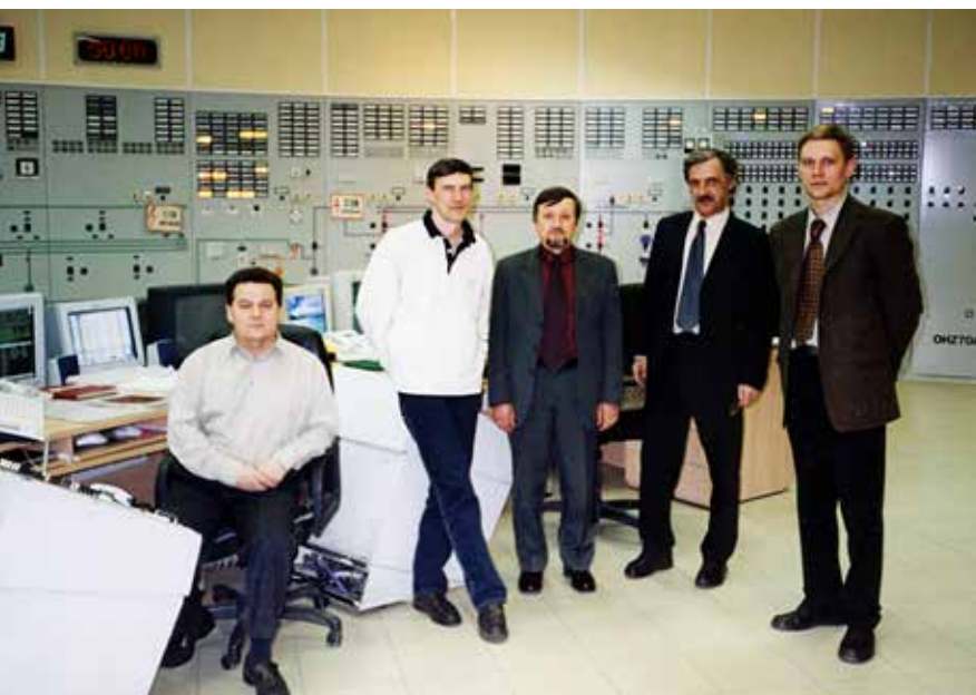
Главный щит управления Нижневартовской ГРЭС (Максим Бабин справа), 2002 год
