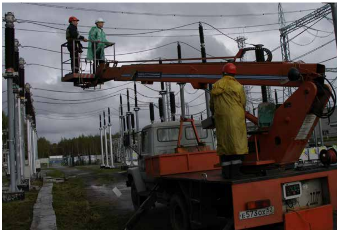
Установка в опытную эксплуатацию опытного образца РЗМЗ на ОРУ 220 кВ ПС 500 кВ Нижегородская, 2013 г.
