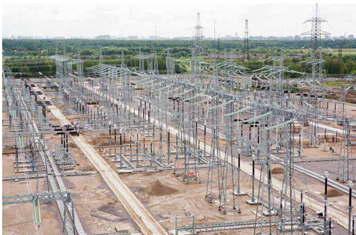
ПС 330 кВ «Восточная»
