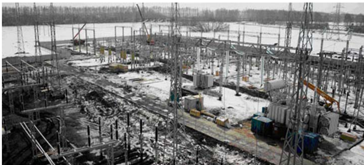
ПС Саратовская в ходе реконструкции
