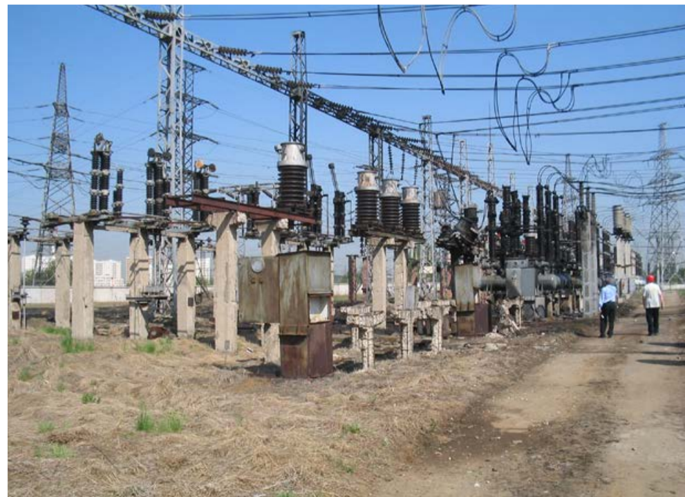
Последствия пожара на подстанции Чагино
