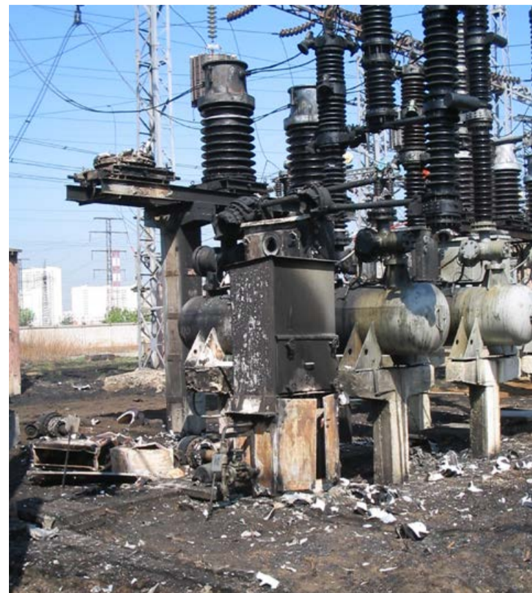
Последствия пожара на подстанции Чагино
