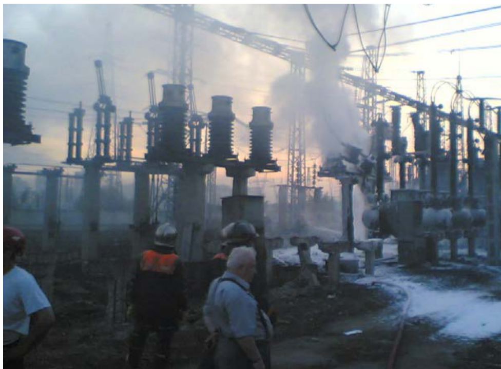
Тушение пожара на подстанции Чагино
