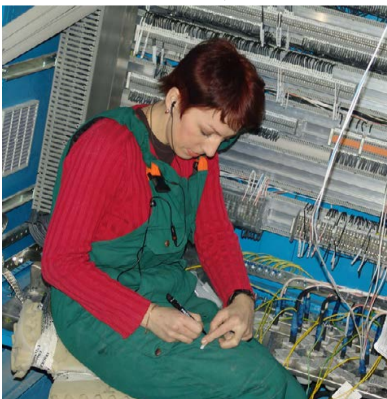
Декабрь 2007 года. Монтаж панелей релейной защиты и автоматики оборудования КРУЭ 110/220 кВ на ПС Чагино
