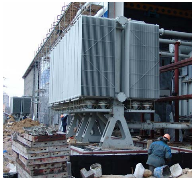
Декабрь 2007 года. Монтаж системы охлаждения автотрансформатора 220 кВ на подстанции Чагино
