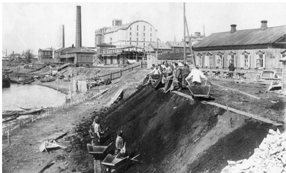
Строительство Саратовской ГРЭС
