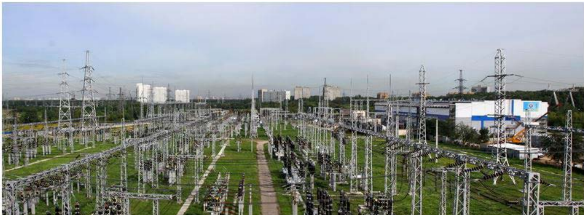
Сентябрь 2009. Подстанция 500 кВ Чагино
