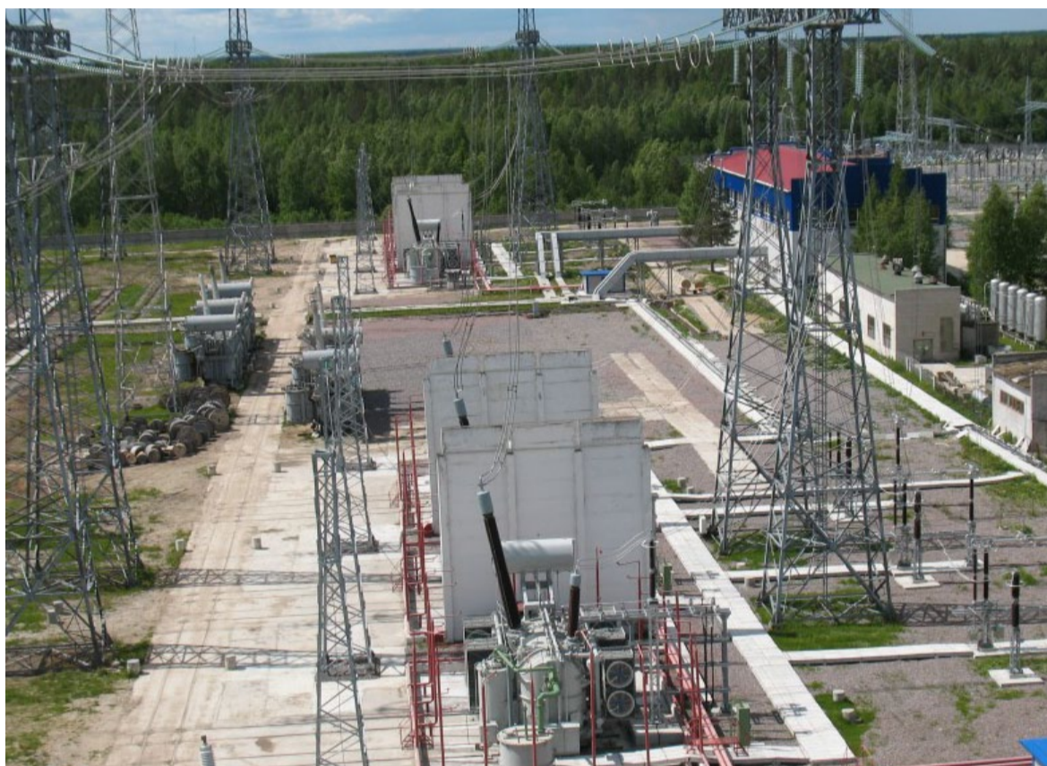
ПС 750 кВ Ленинградская
