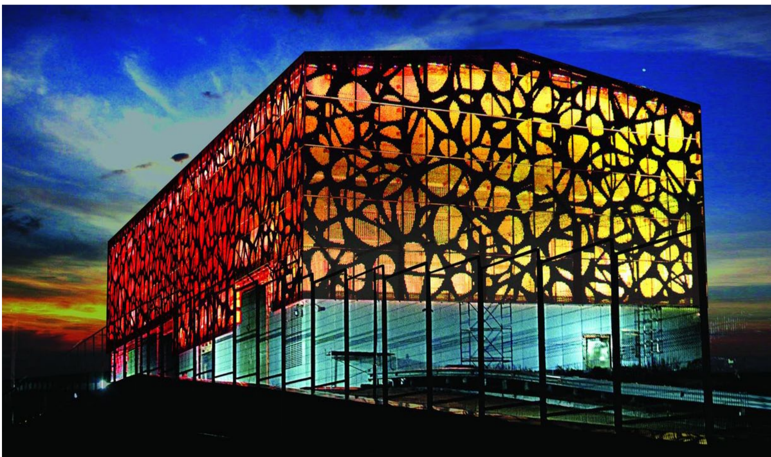
Олимпийский энергообъект: подстанция Роза Хутор
