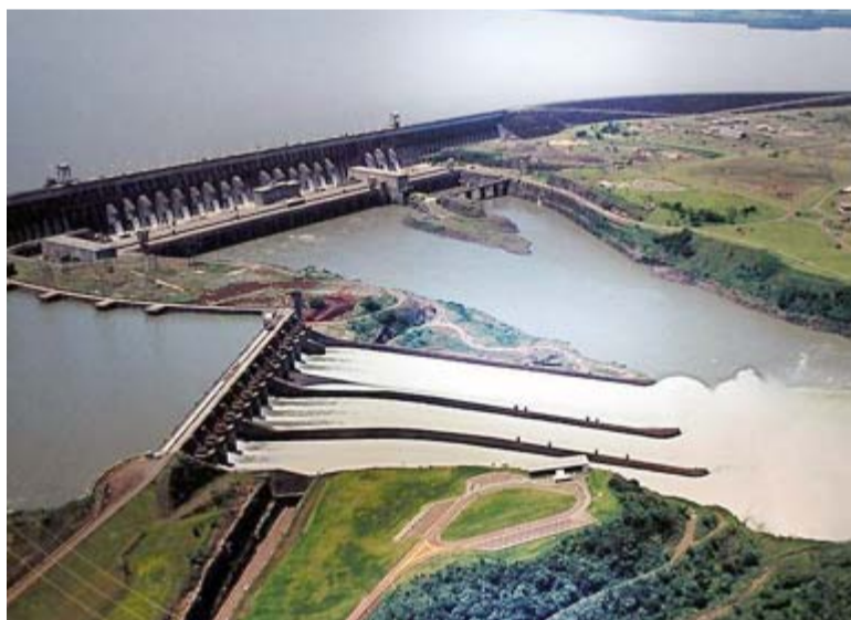
ГЭС Итайпу (14 000 МВт), каскад ГЭС на реке Парана (Бразилия)
