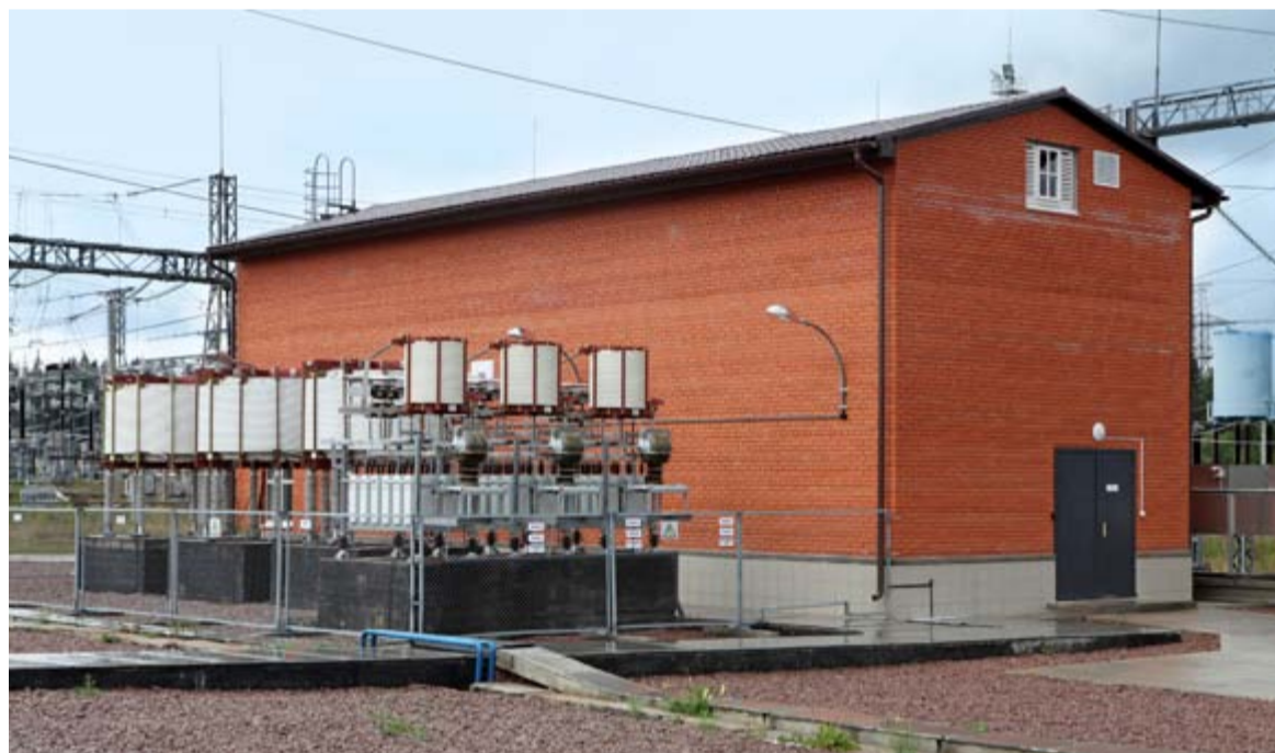
Статический компенсатор реактивной мощности (50 МВАр), ПС 400 кВ Выборгская
