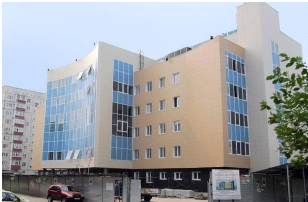
Строящееся здание Тюменского РДУ
