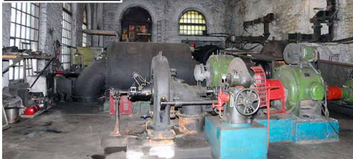
Машинный зал ГЭС Пороги
