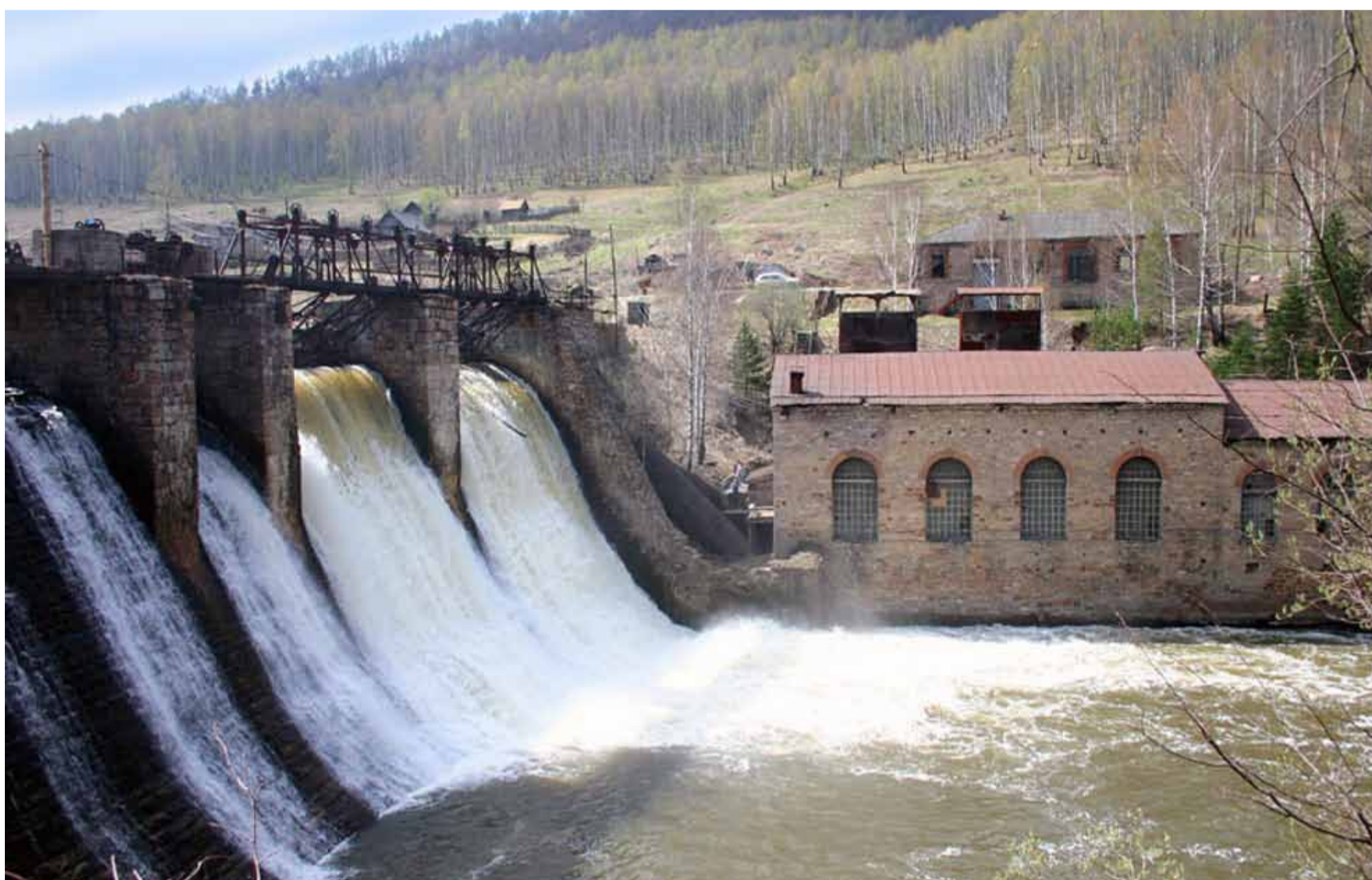
ГЭС «Пороги» на реке Сатка
