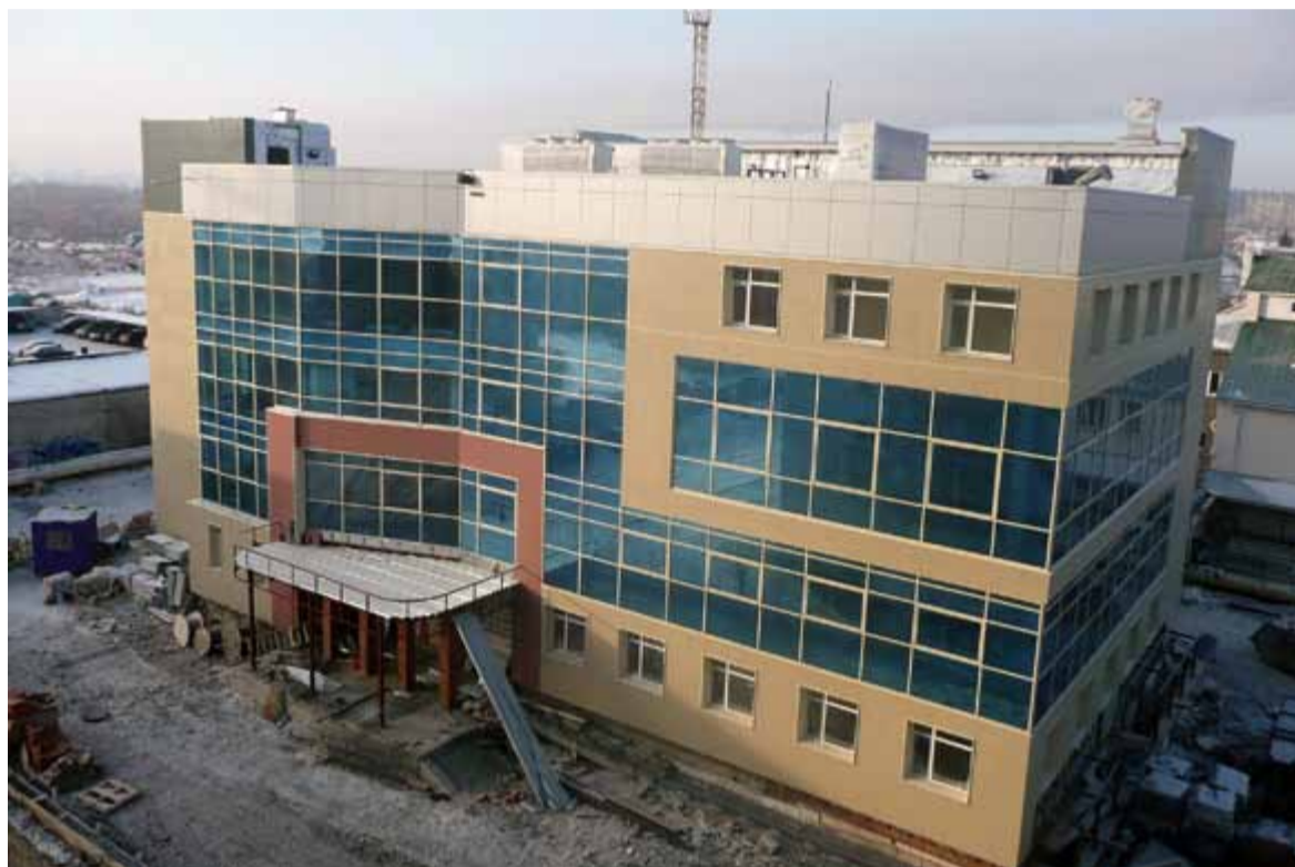
Идет строительство нового здания диспетчерского центра
