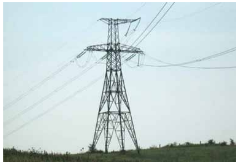
ЛЭП 330 кВ Владикавказ – Чирюрт
