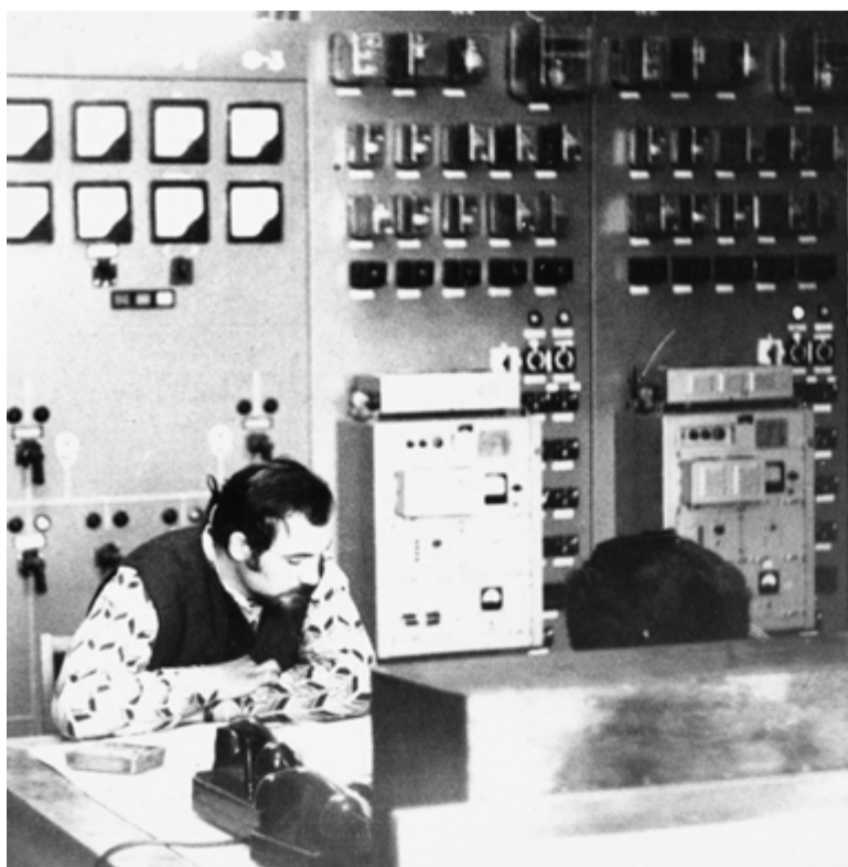
Наладка каналов противоаварийной автоматики на ПС 220 Осакарровка. 1978 год.
