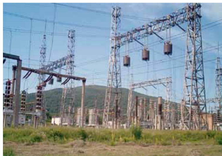
Подстанция Машук – первая на Северном Кавказе подстанция 330 кВ
