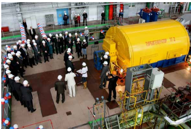
Приморское РДУ выполнило работы по режимному обеспечению ввода турбогенератора №2 на Партизанской ГРЭС
