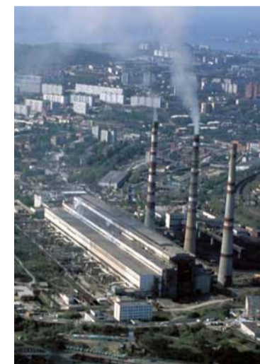
Шесть котлоагрегатов Владивостокской ТЭЦ-2 будут переведены с угля на газ
