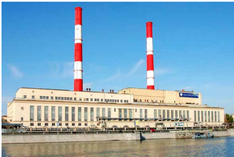
В 1966 году мощность реконструированной ТЭЦ-12 достигла 110 МВт
