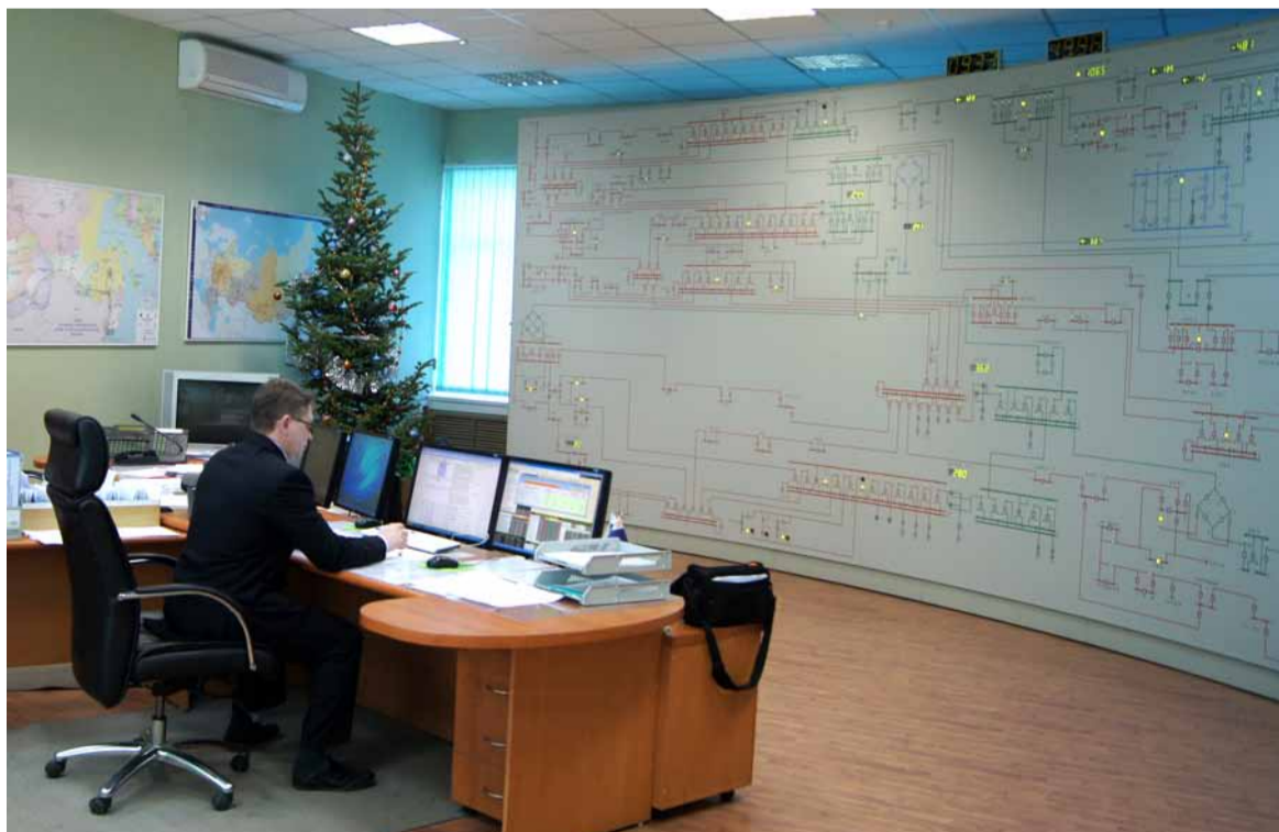
Диспетчерский центр Приморского РДУ
